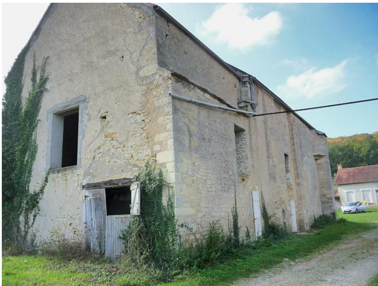
Murs postérieur et gauche de la chapelle.
