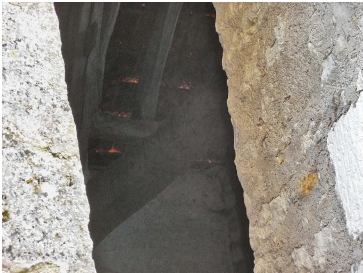
Chapelle, corps antérieur : détail de la charpente.
