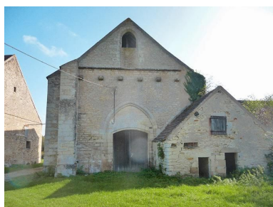
Façade de la chapelle et petite dépendance. Phot. Cécile Lestienne, Phot. Virginie Malherbe IVR26_20128900278NUC2A
