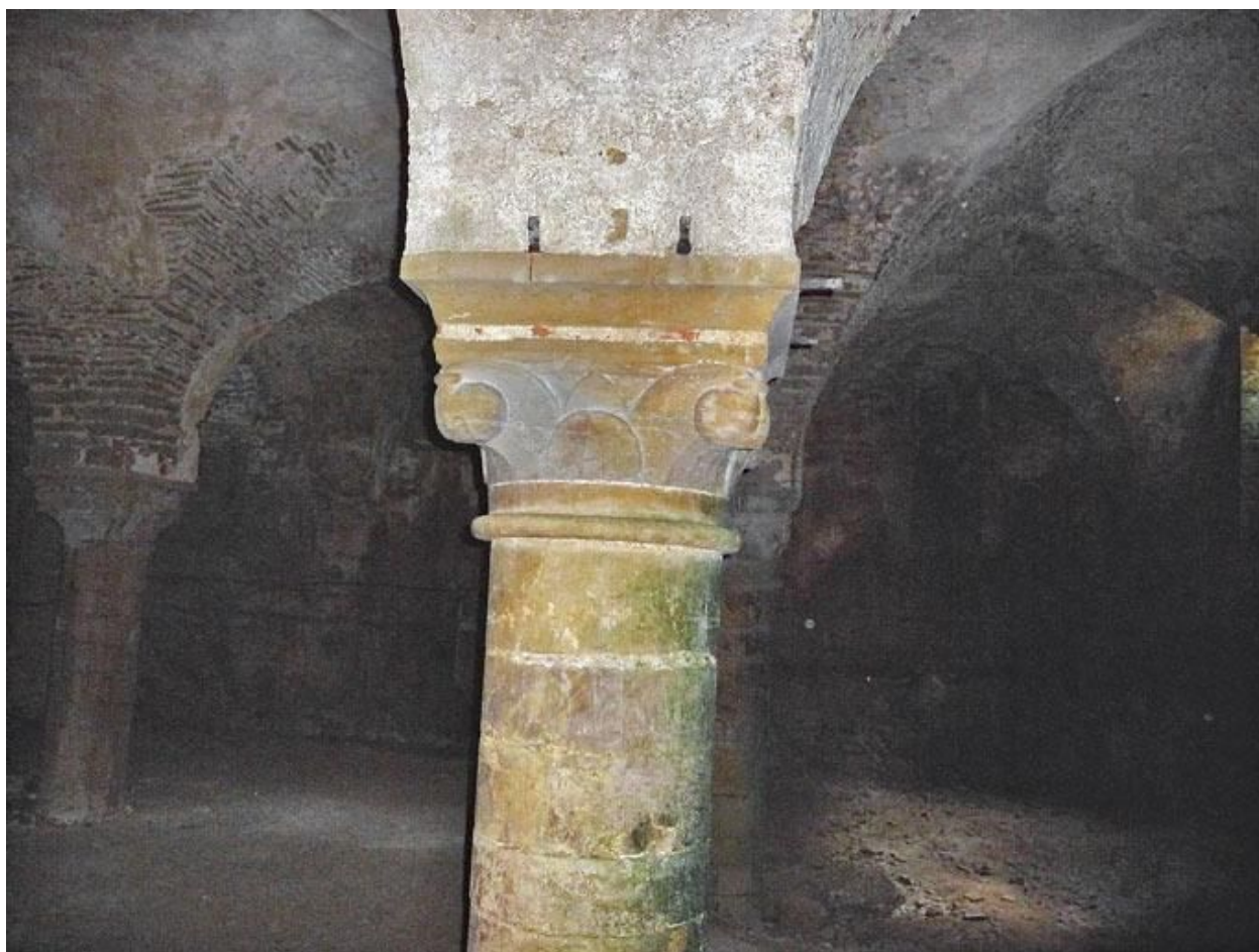
Cave sous la grange, colonne.
