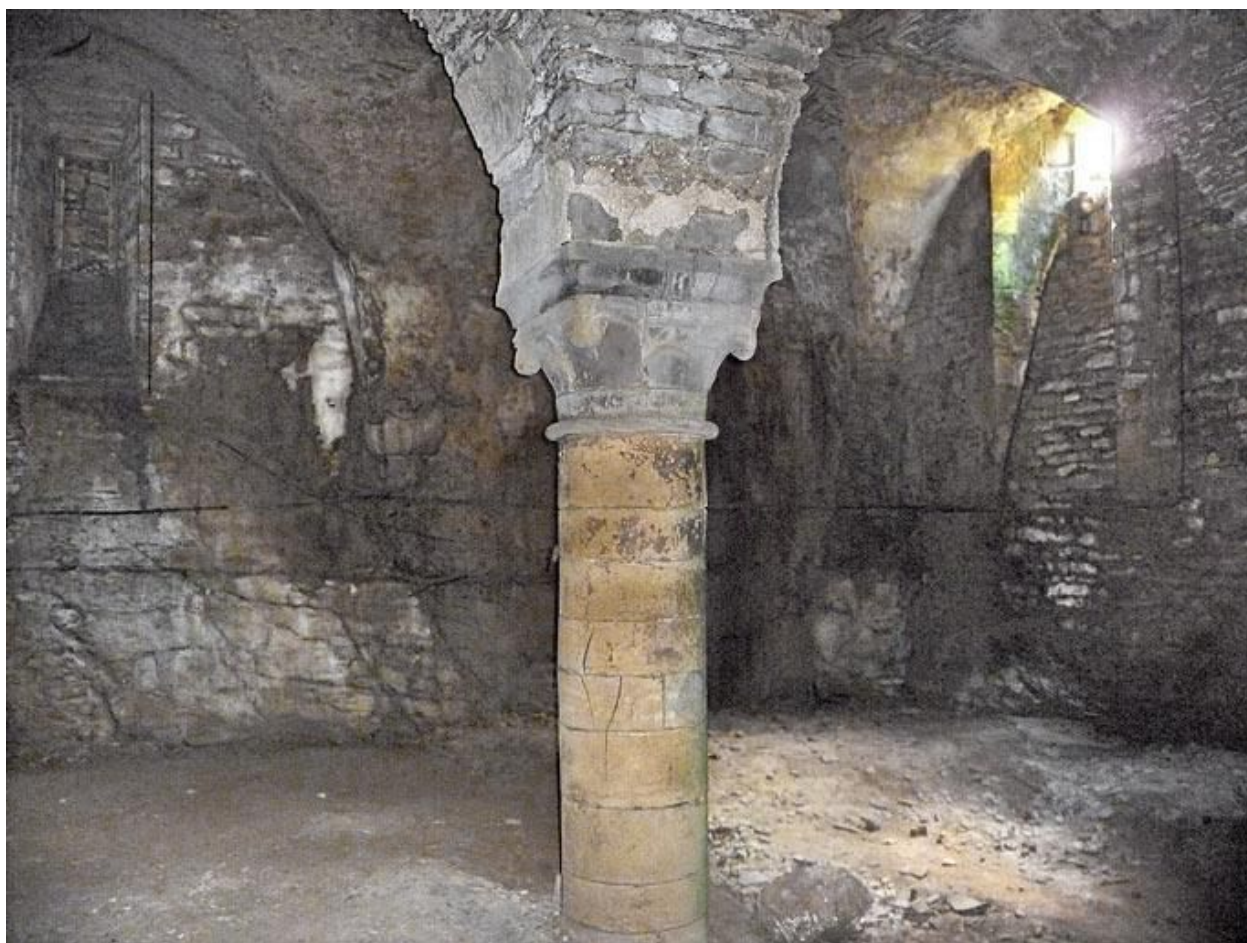
Cave sous la grange, vue d'un angle.
