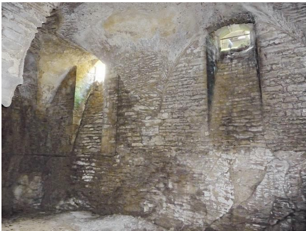
Cave sous la grange : voûte et soupiraux.
