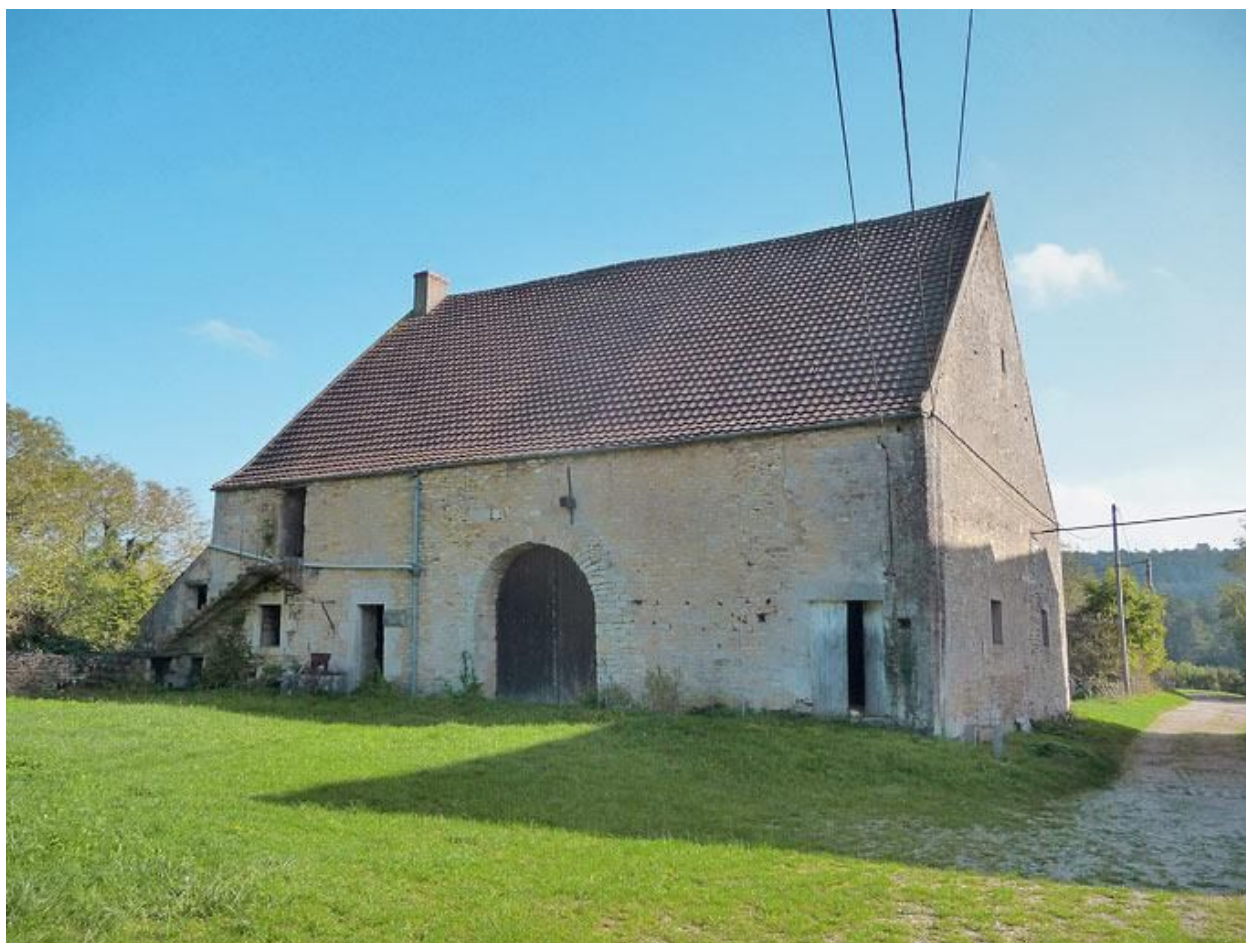
Façade de la grange.
