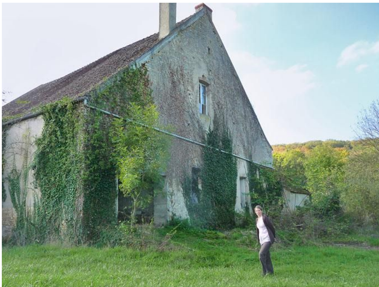
Mur gauche de la grange.
