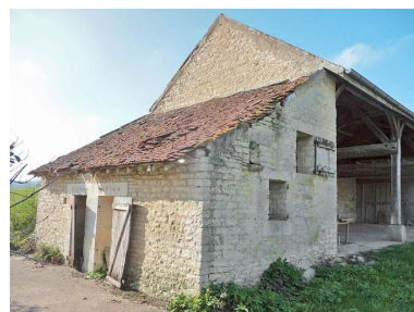
Petite dépendance prolongeant le hangar. Phot. Cécile Lestienne, Phot. Virginie Malherbe IVR26_20128900288NUC2A
