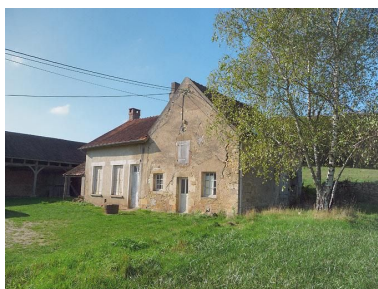
Maison d'habitation de la ferme. Phot. Cécile Lestienne, Phot. Virginie Malherbe IVR26_20128900277NUC2A
