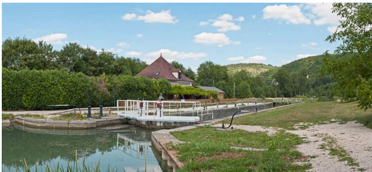
Vue d'ensemble du site d'écluse.
