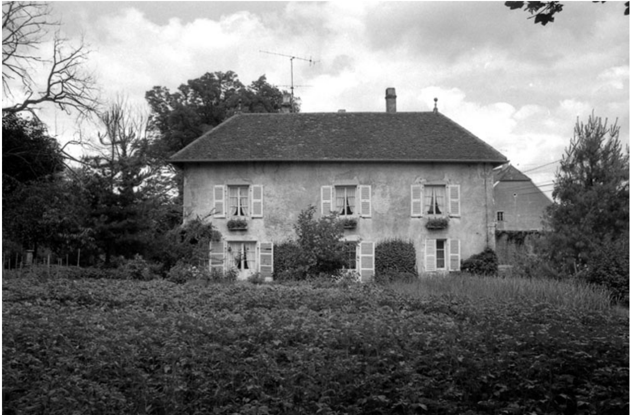
Façade postérieure de l'habitation.
