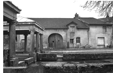
Ferme située rue Sainte-Anne. Phot. Yves Sancey IVR43_19817000026X
