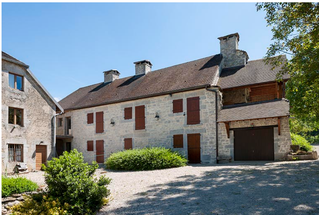
Logement d'ouvriers. Vue de trois quarts.
