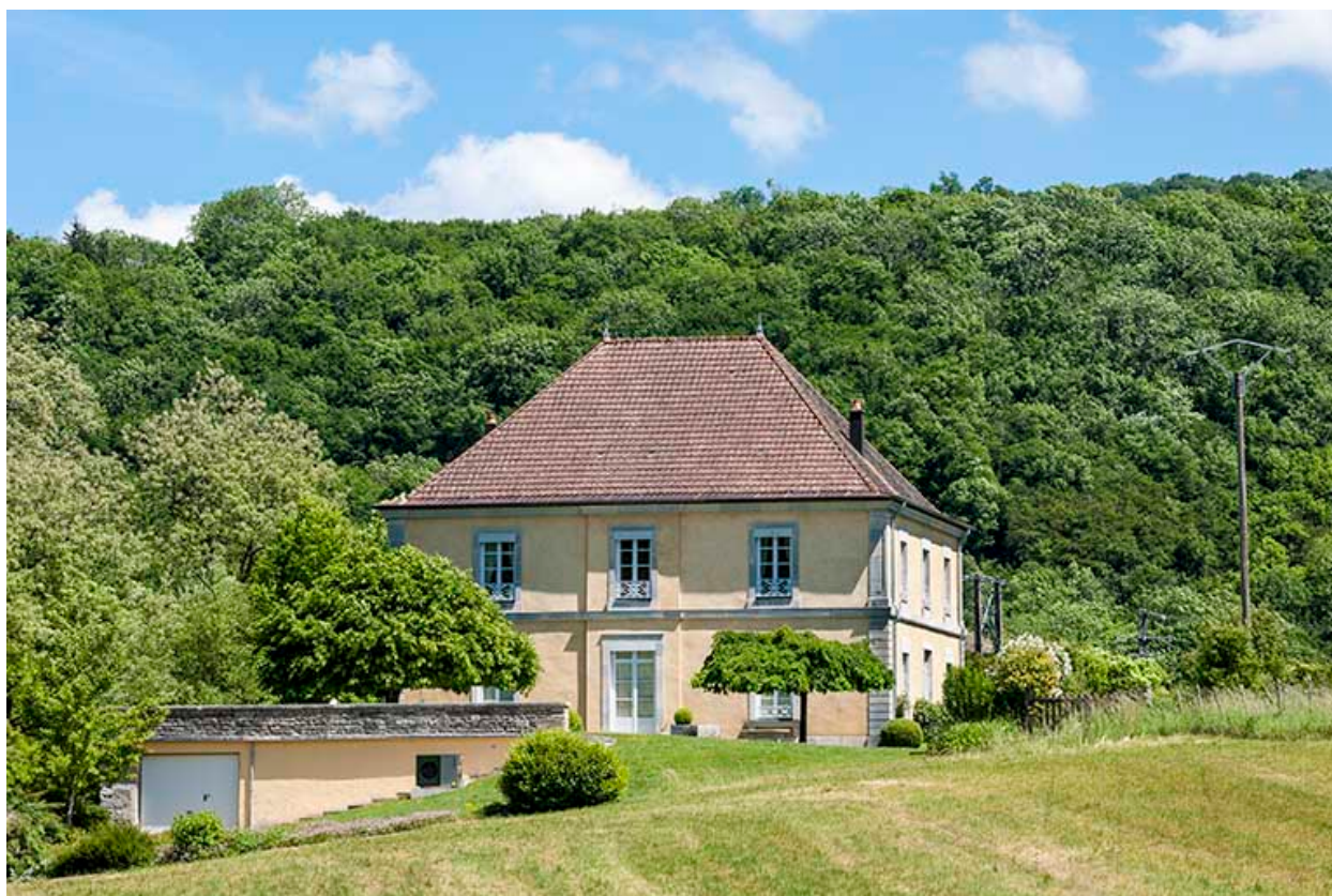
Logement patronal depuis l'ouest.
