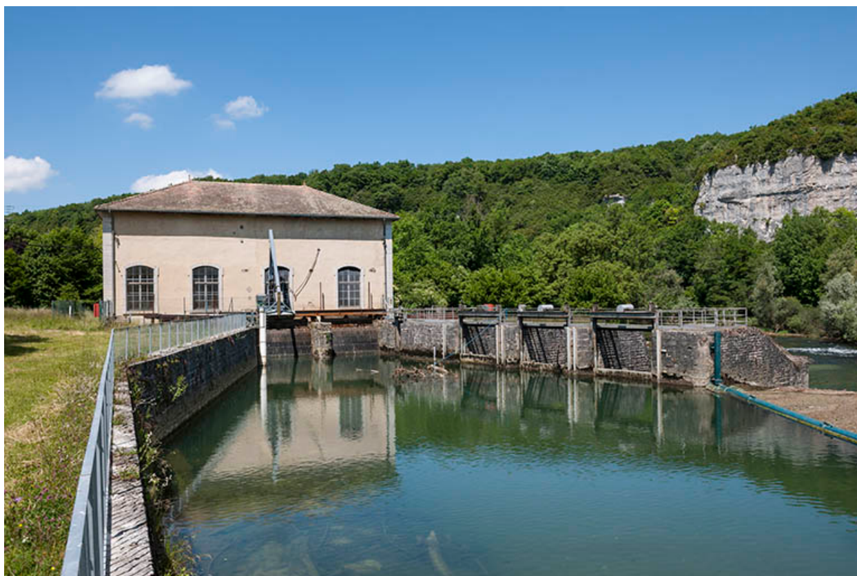
La centrale et son déversoir, depuis l'amont.
