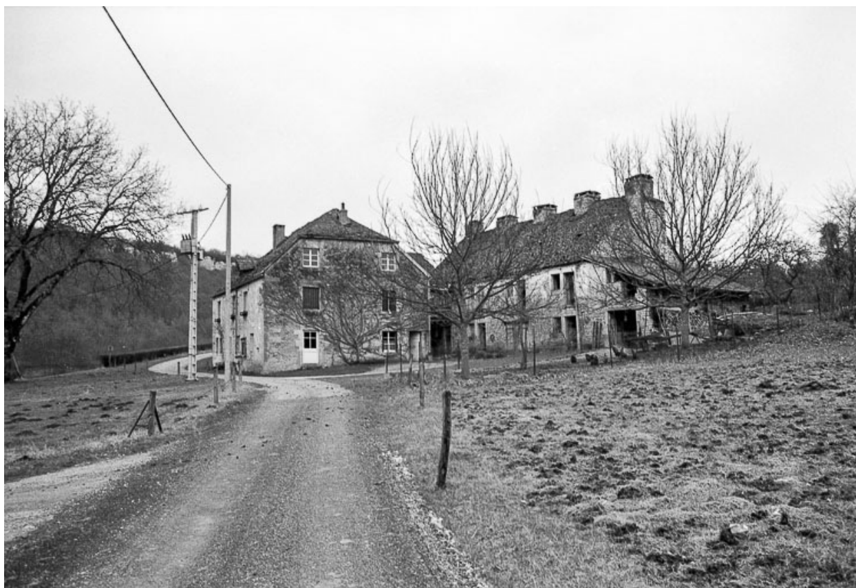
Logements d'ouvriers depuis l'ouest en 1979.
