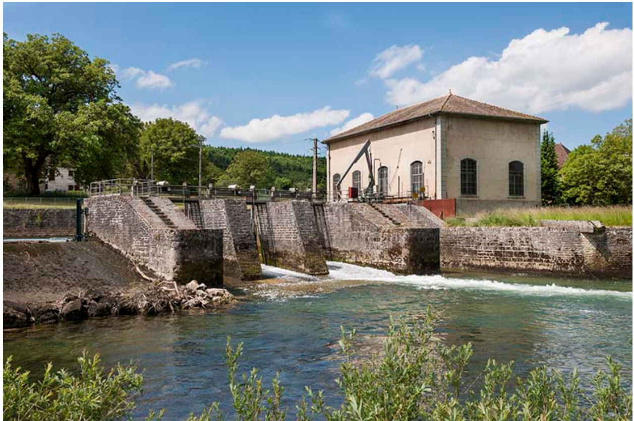
La centrale hydroélectrique et son déversoir.
