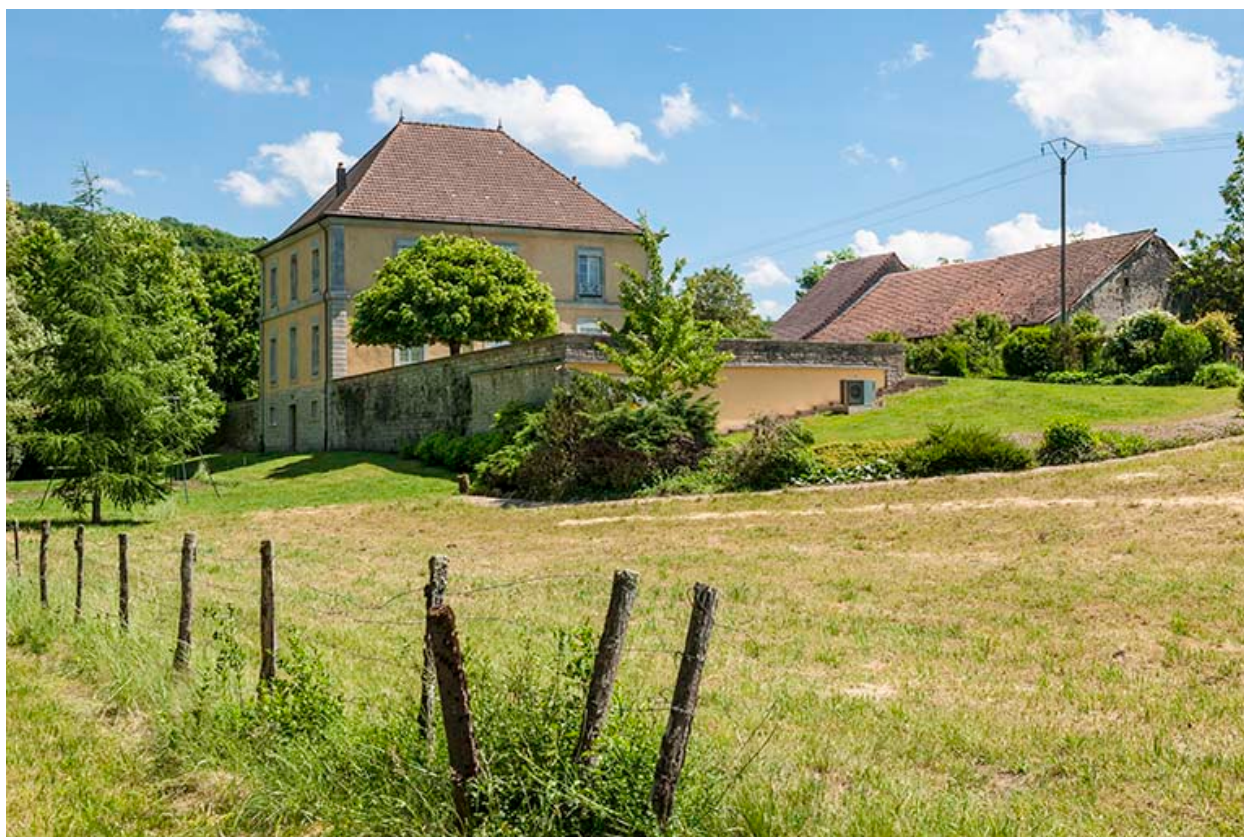
Logement patronal depuis le nord-ouest.
