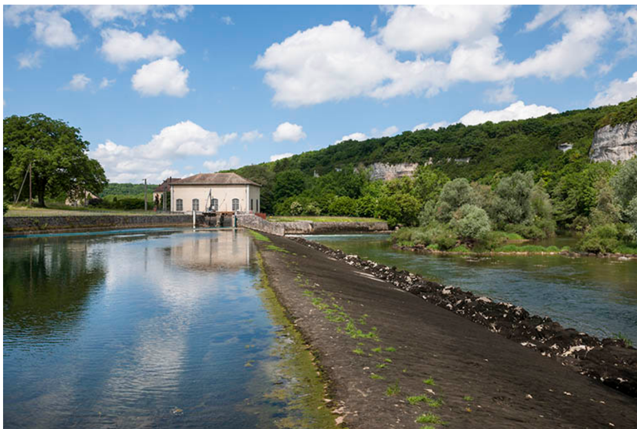
Le barrage de la centrale hydroélectrique.
