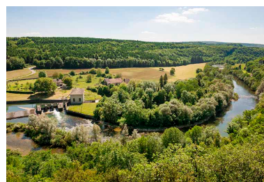
Vue plongeante d'ensemble depuis le nord-est. Phot. Jérôme Mongreville IVR43_20152501225NUC4A
