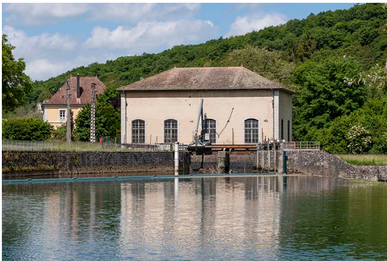
La centrale hydroélectrique vue depuis l'est.
