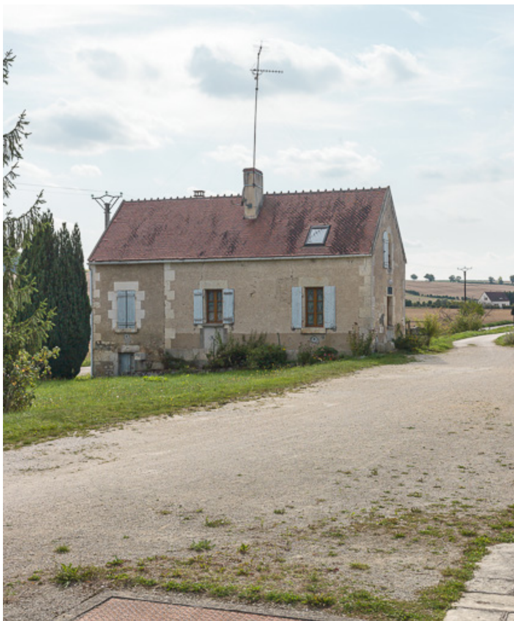
Vue de la maison éclusière.
