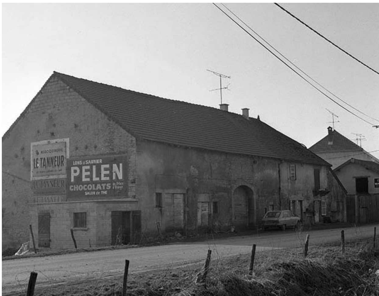
3e ferme : façades antérieure et latérale gauche.
