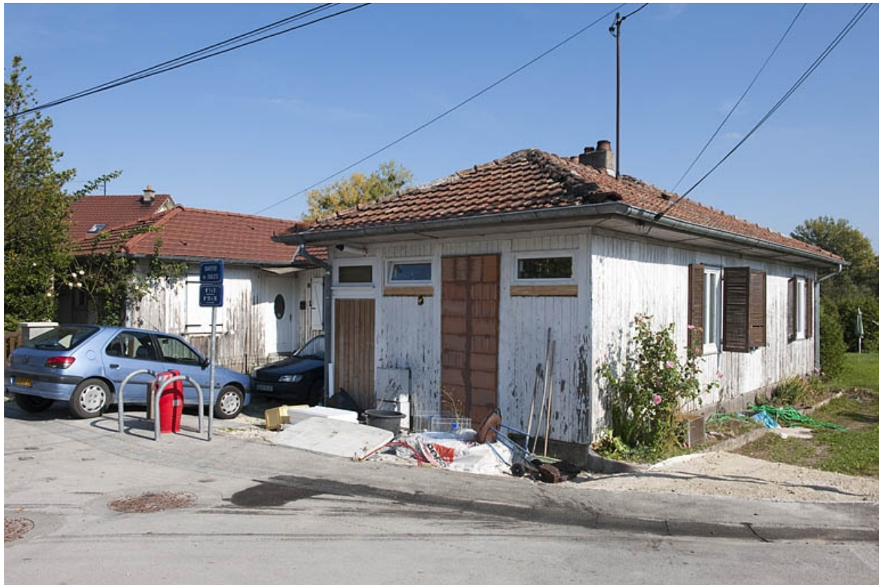
Maison jumelée (n°8-10) vue de trois quarts.
