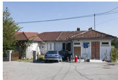
Maison jumelée vue de face.
