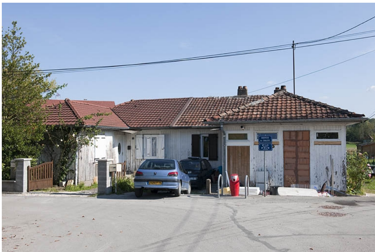
Maison jumelée vue de face.
