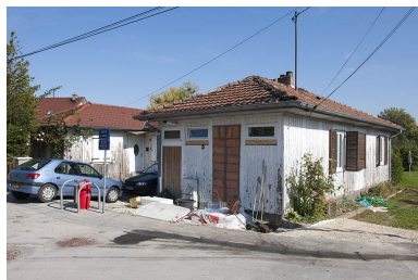
Maison jumelée (n°8-10) vue de trois quarts.
