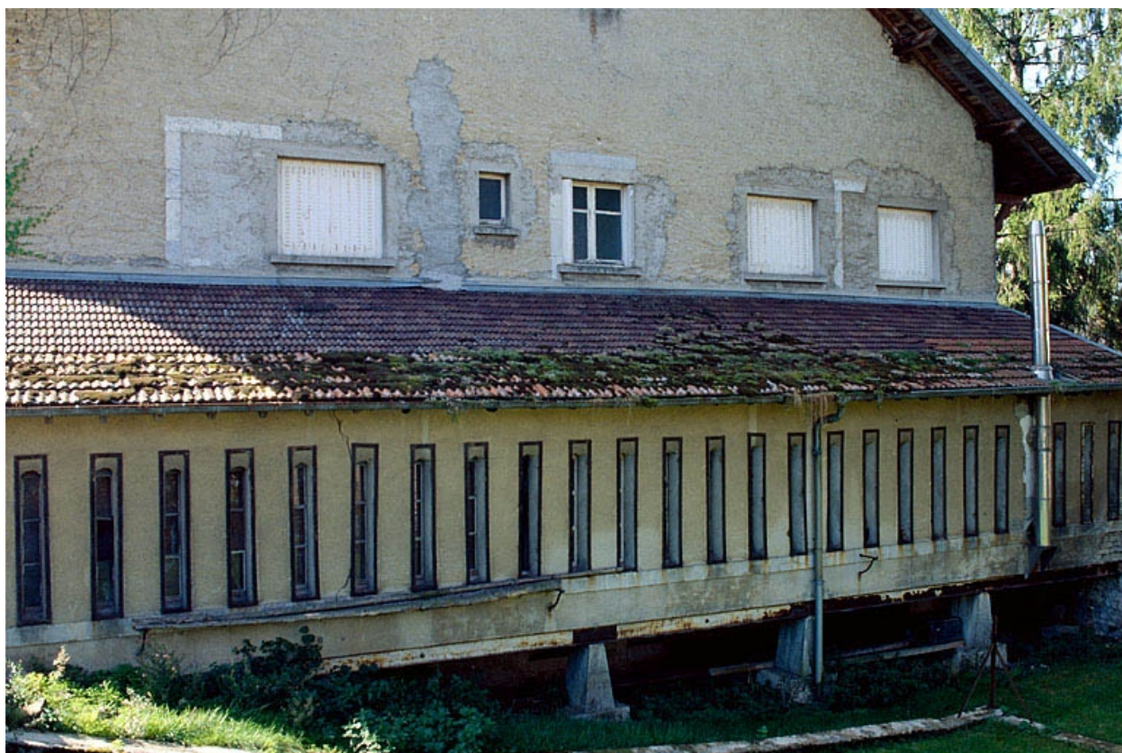
Ancienne chambre à lait en façade postérieure.
