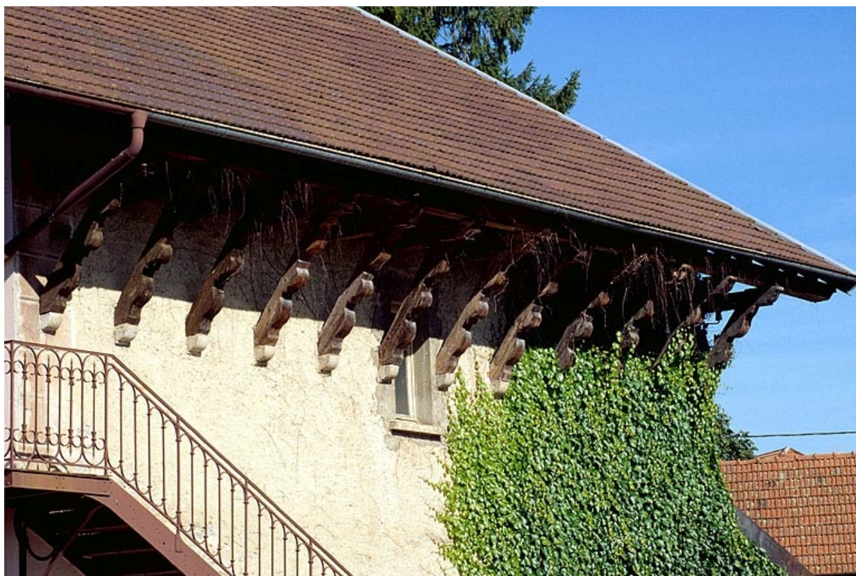
Aisseliers sculptés sur la façade orientale.
