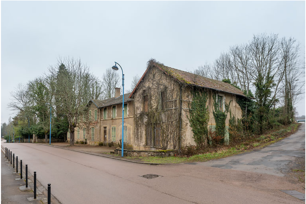
Façade principale, vue depuis le sud-est.
