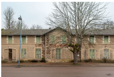
Partie centrale de la façade principale, vue de face.
