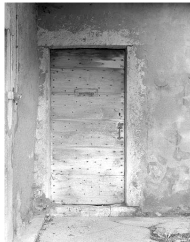
Porte d'accès au logis du rez-de-chaussée. Phot. Jérôme Mongreville IVR43_19943901129X
