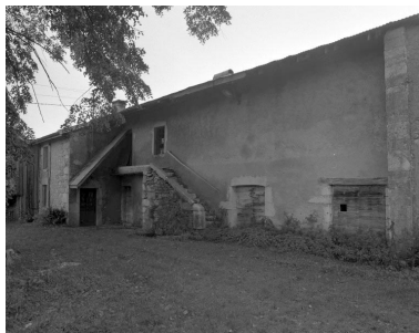
Façade antérieure. Phot. Jérôme Mongreville IVR43_19943901130X
