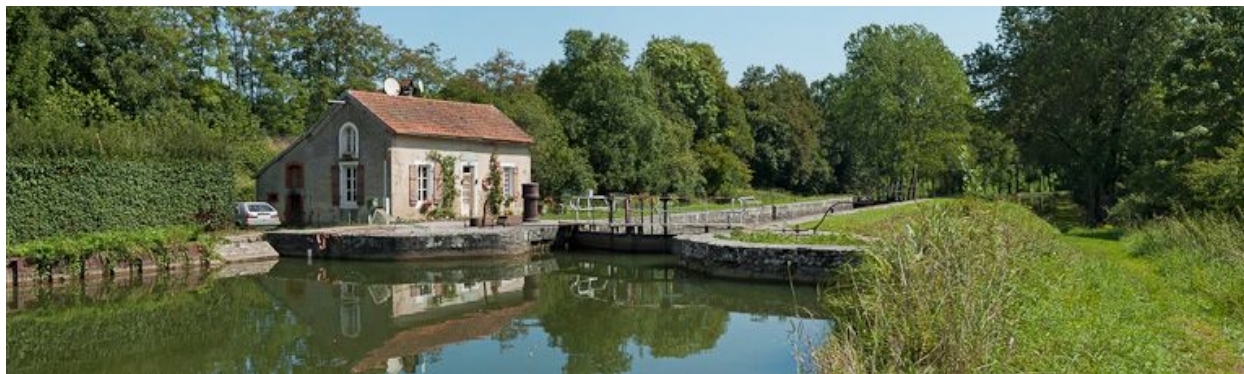
Vue du site d'écluse.
