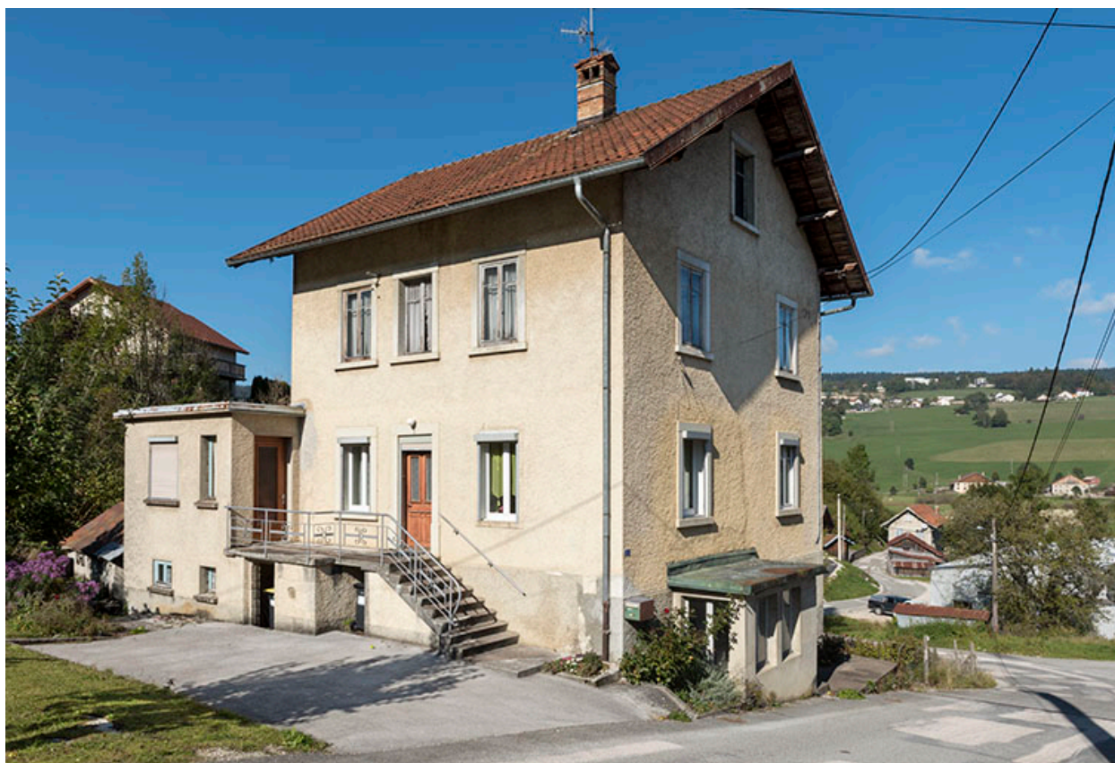
Façades antérieure et latérale gauche.
