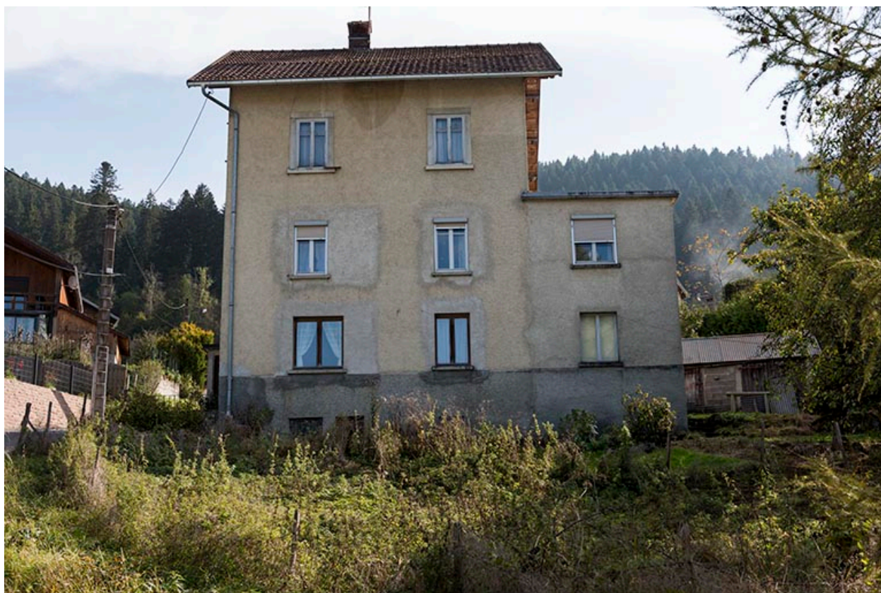
Façade latérale droite, vue en contre-plongée.
