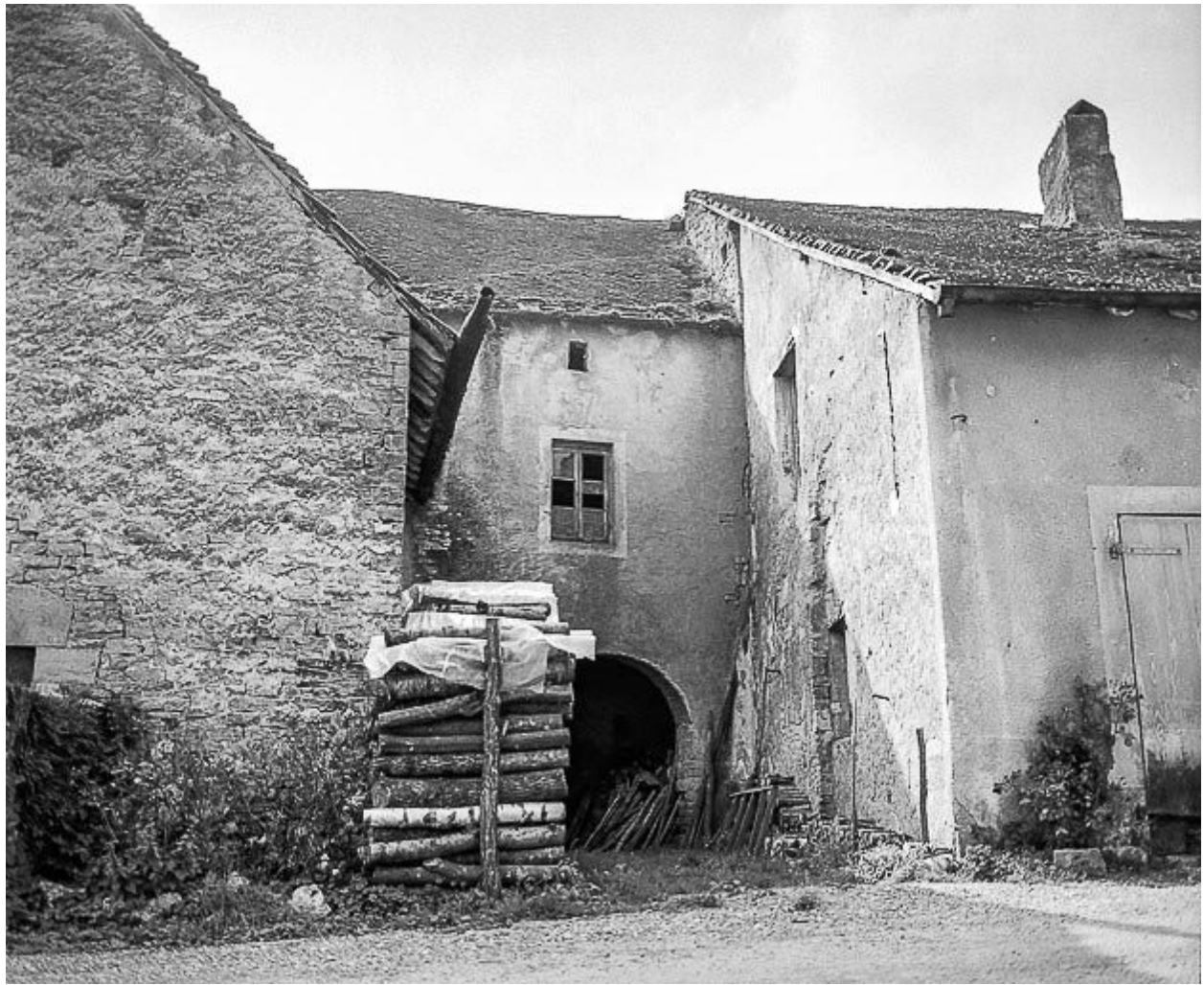
Détail de la façade postérieure.
