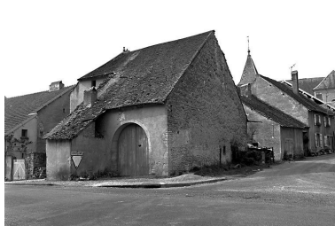
Façade sur rue des parties agricoles. Phot. Yves Sancey IVR43_19777000405X
