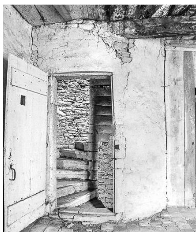
Tourelle d'escalier au niveau du 1er étage. Phot. Yves Sancey IVR43_19777000408X
