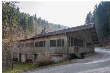
Atelier de scierie depuis le nord-ouest.
