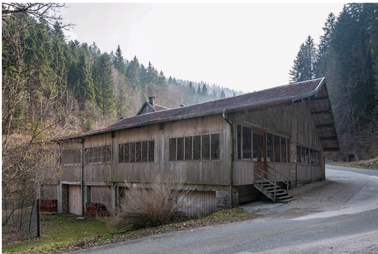
Atelier de scierie depuis le nord-ouest.
