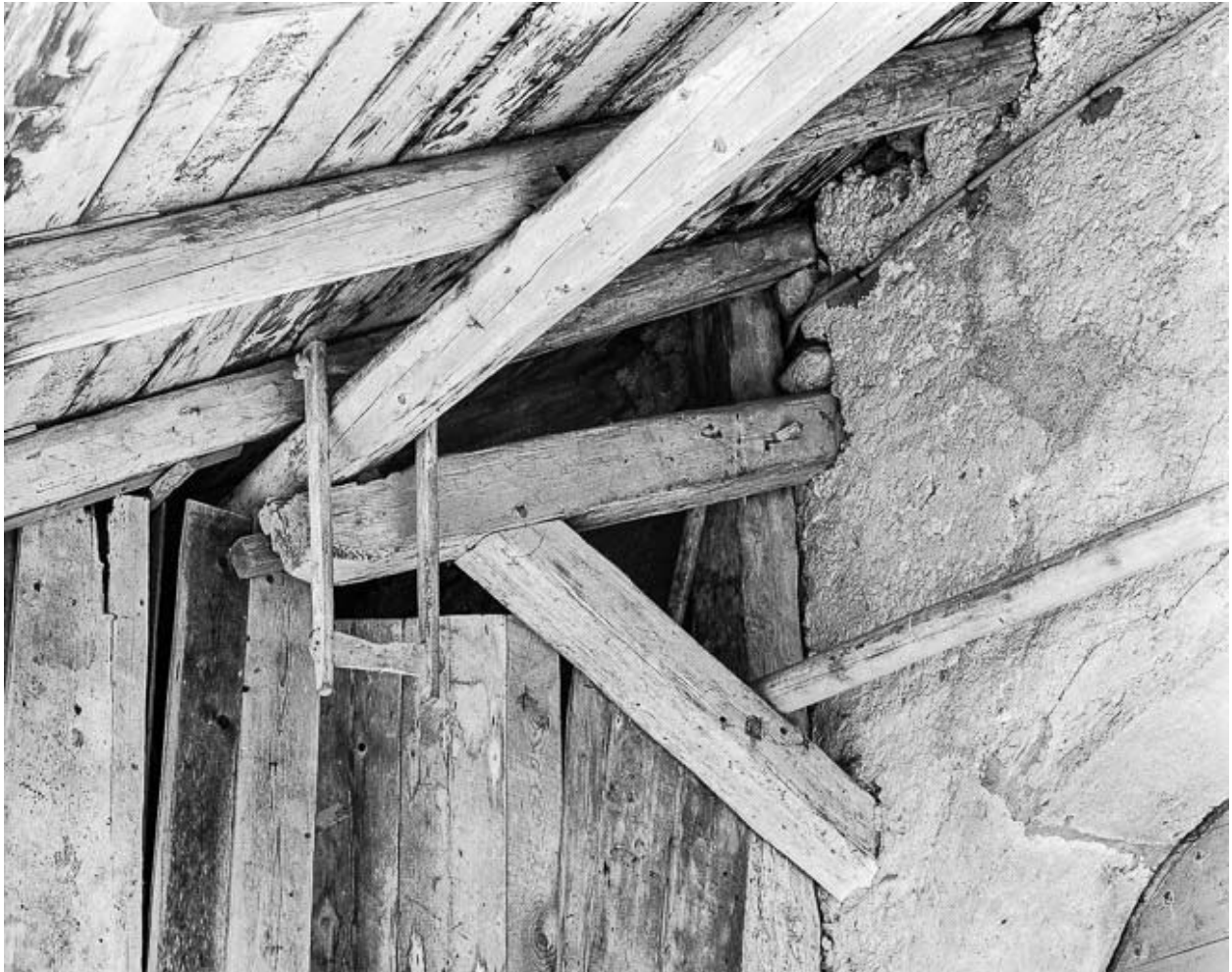
Auvent sur goutterot, côté gauche.
