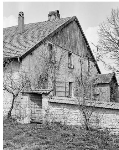
Façade antérieure. Phot. Dominique Dominguez IVR43_19792500070X
