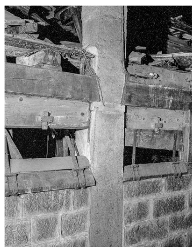
Partie inférieure en pierre de taille d'un poteau de charpente. Phot. Dominique Dominguez IVR43_19792500076X
