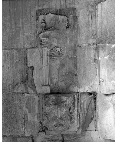
Collatéral gauche, lavabo. IVR26_19728900531X
