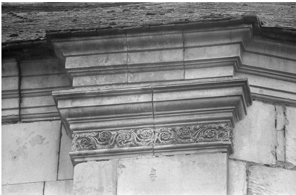
Détail d'un pilastre du chevet.
