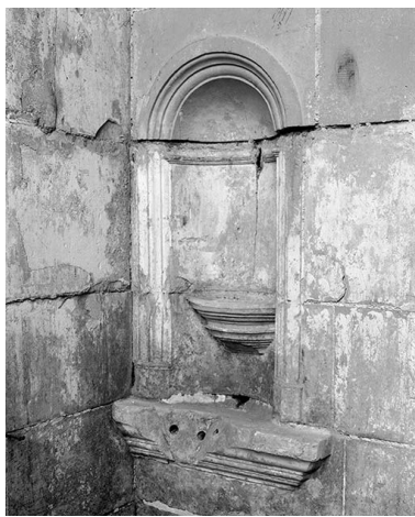
Chapelle sous clocher, lavabo. IVR26_19728900532X
