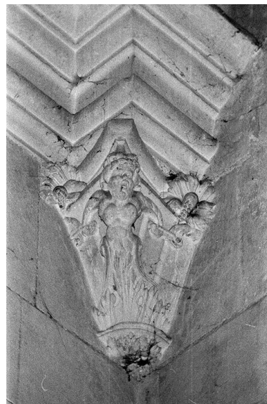
1ère chapelle rayonnante, culot antérieur gauche. IVR26_19728900566Z
