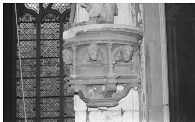
2ème pilier du rond-point, console. IVR26_19728900569Z
