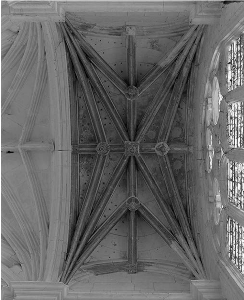
Voûtement d'une des chapelles latérales.
