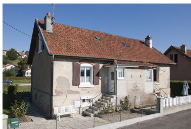
Maison jumelée. Vue de trois quarts. Phot. Jérôme Mongreville IVR43_20112502399NUC4A
