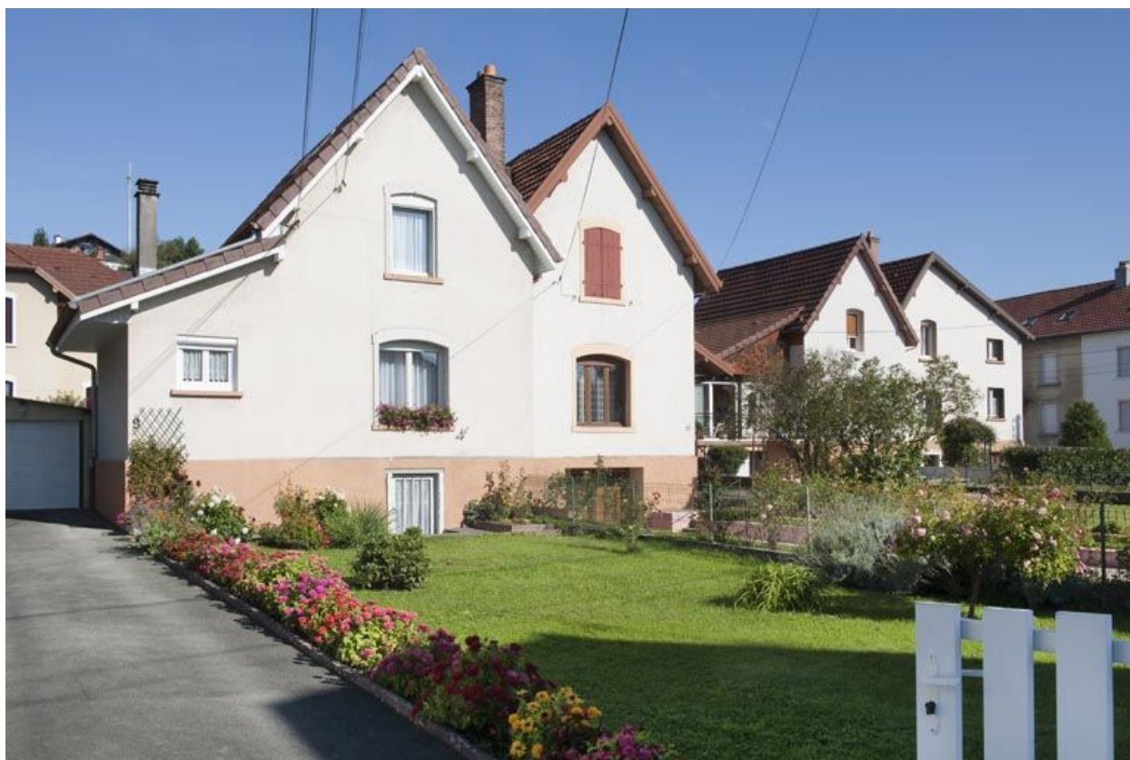
Maisons de cadre rue de la Croze.
