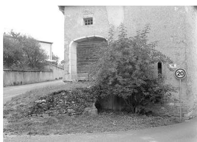
Accès à la grange haute par un pont de grange. Phot. Jérôme Mongreville IVR43_19963901131X
