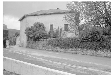
Face sud depuis la rue du curé Marquis. Phot. Jérôme Mongreville IVR43_19963901130X
