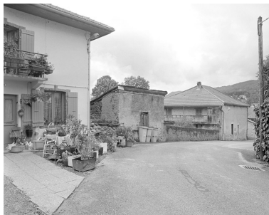
Vue générale, au premier plan : la remise. Phot. Jérôme Mongreville IVR43_19963901127X
