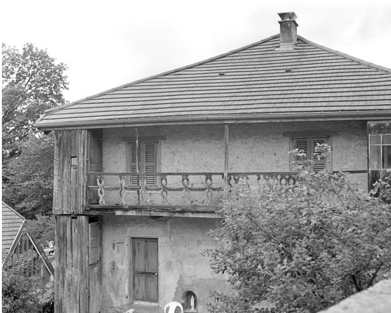
Balcon en galerie sur la façade antérieure.
