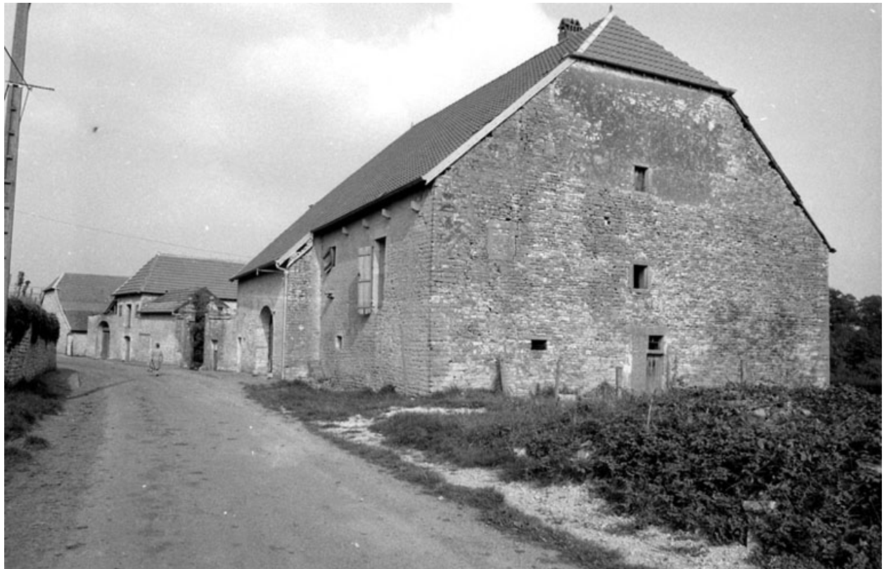
Façade antérieure et latérale droite.
