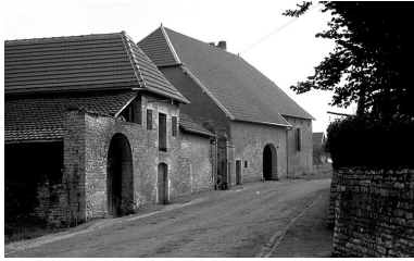
Façade sur rue. Phot. Bernard Lardière IVR43_19797000063Z
