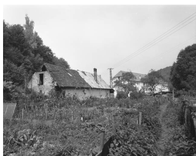
Magasin industriel situé derrière la filature en 1981.
