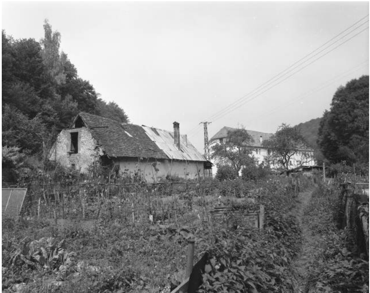
Magasin industriel situé derrière la filature en 1981.
