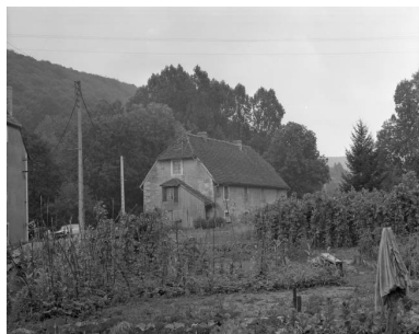
Logement ouvrier depuis le nord en 1981.
