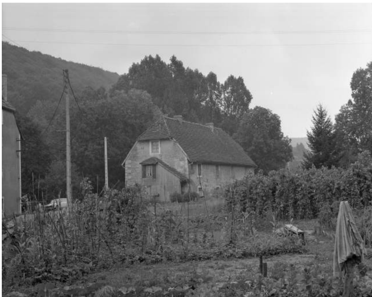
Logement ouvrier depuis le nord en 1981.
