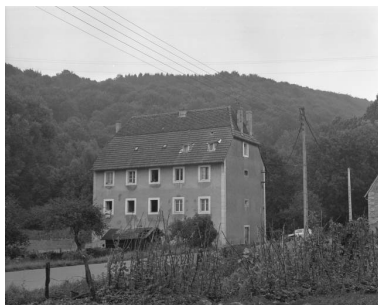
Logement ouvrier vu de trois quarts en 1981.
