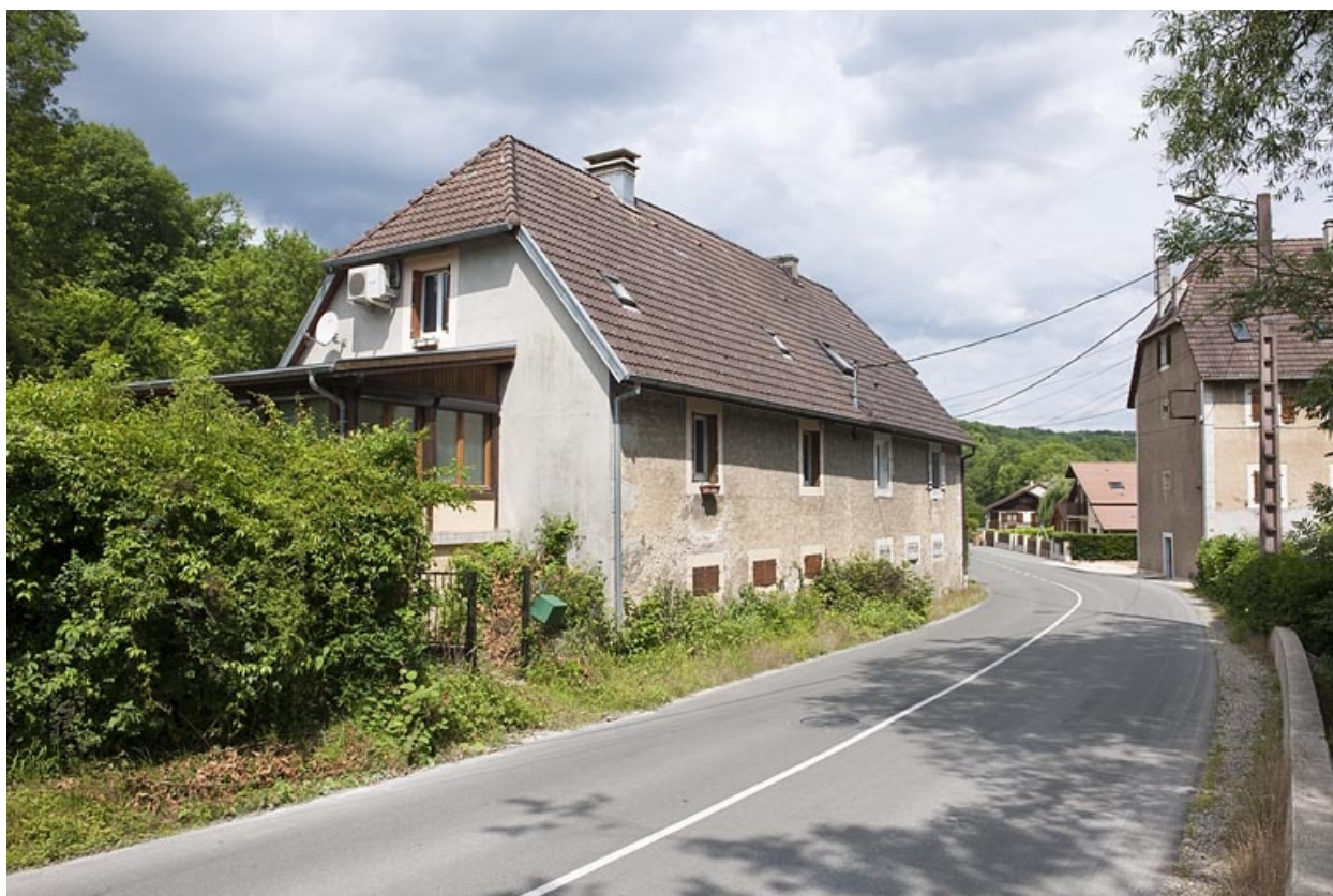
Logement d'ouvriers depuis le sud.
