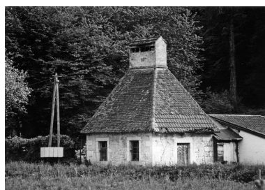
Séchoir-buanderie en 1979. Photographie, 1979. Phot. Raphaël Favereaux, Autr. Tchirakadzé (photographe) IVR43_20122500684NUC2A
