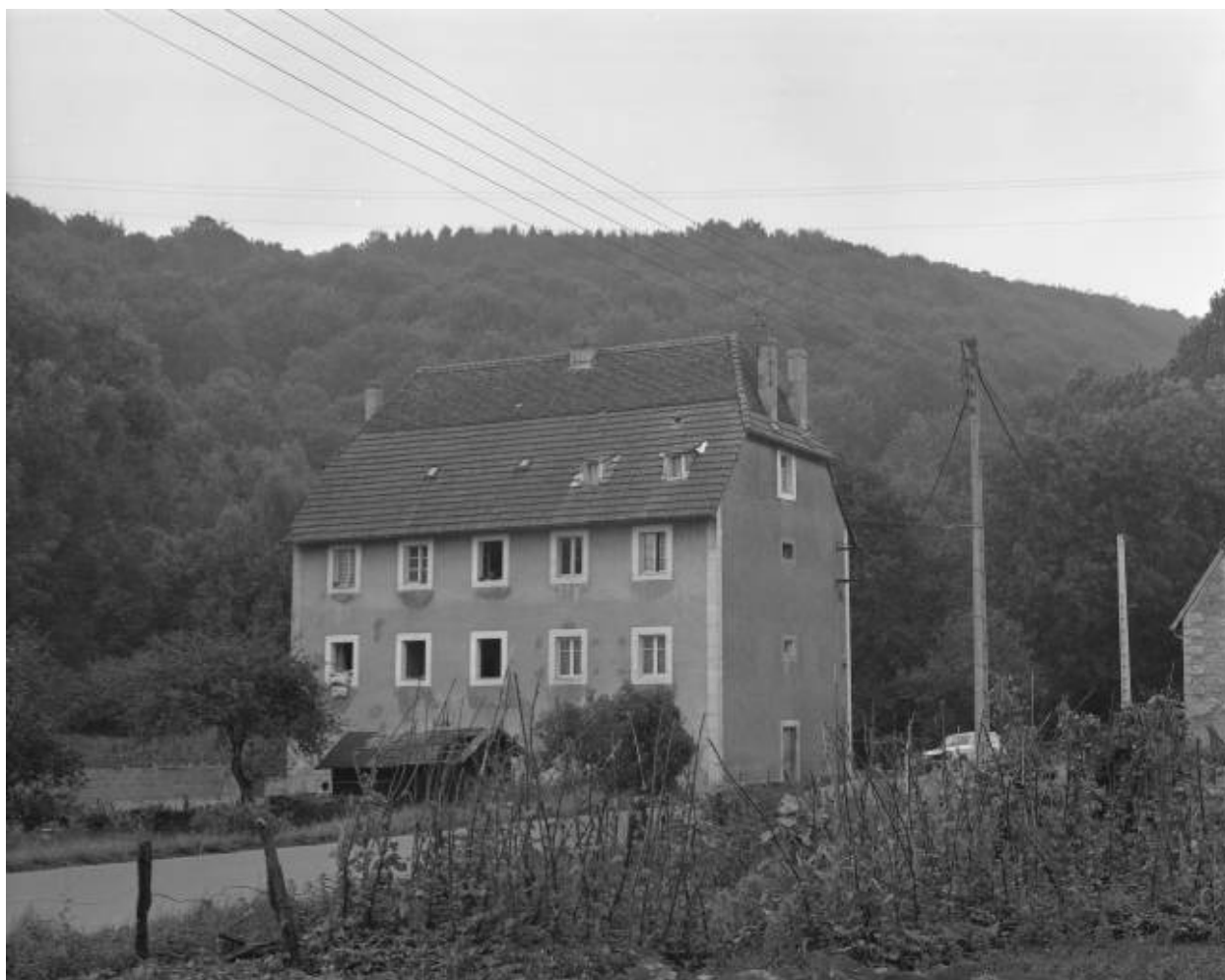
Logement ouvrier vu de trois quarts en 1981.
