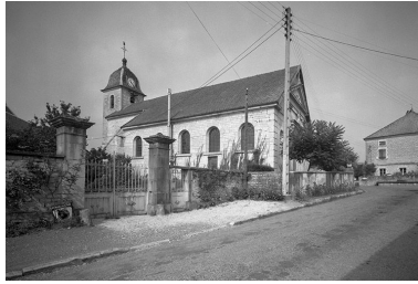
Façade antérieur, face gauche et tour-clocher. Phot. Yves Sancey IVR43_19757000002V
