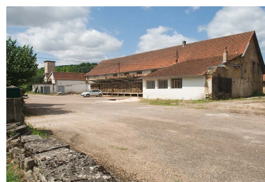
L'atelier de fabrication (filature ?). Phot. Jérôme Mongreville IVR43_20087000704NUC2A
