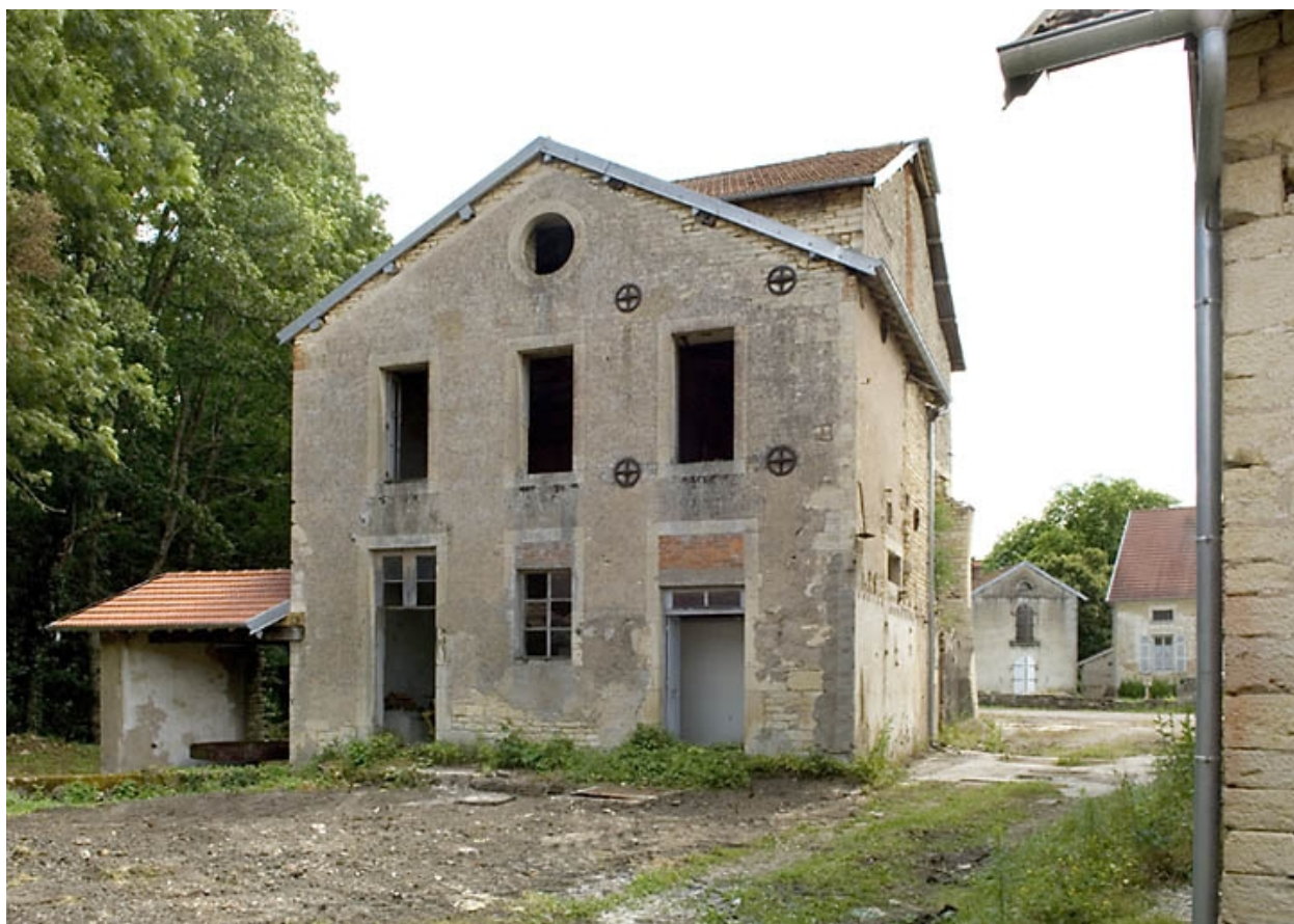
Façade ouest du haut fourneau.
