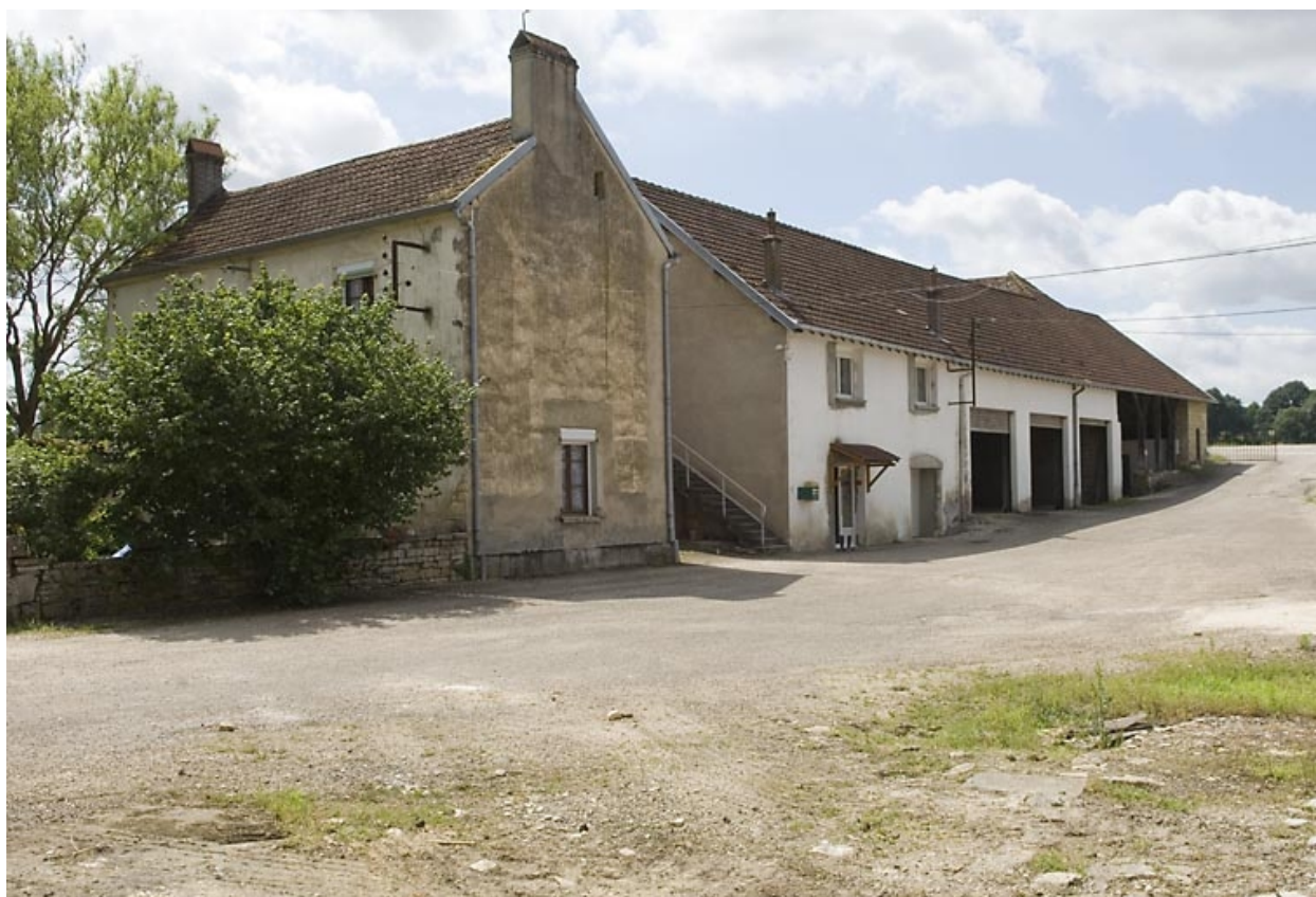
Logement et halle à charbon (remaniée).
