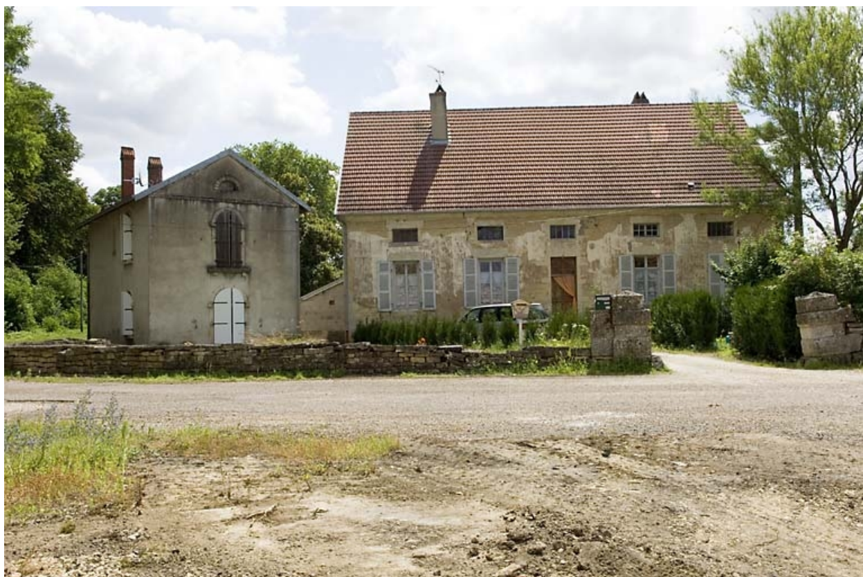
Bureau (?) et logement patronal.
