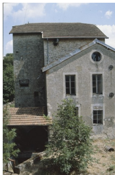
Façade postérieure du haut fourneau en 1989. Phot. Yves Sancey IVR43_19897000771ZA
