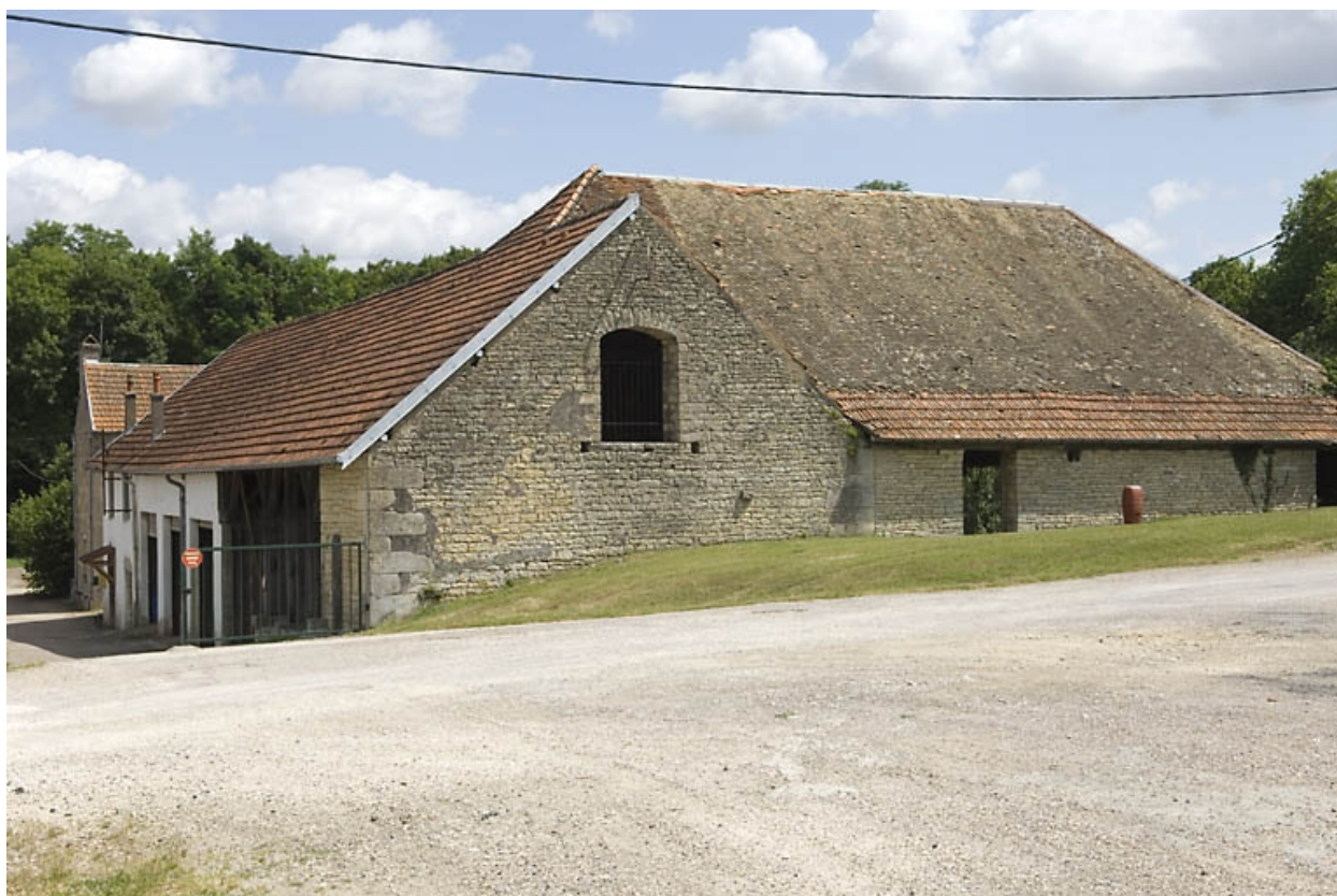
Halle à charbon depuis le sud-est.
