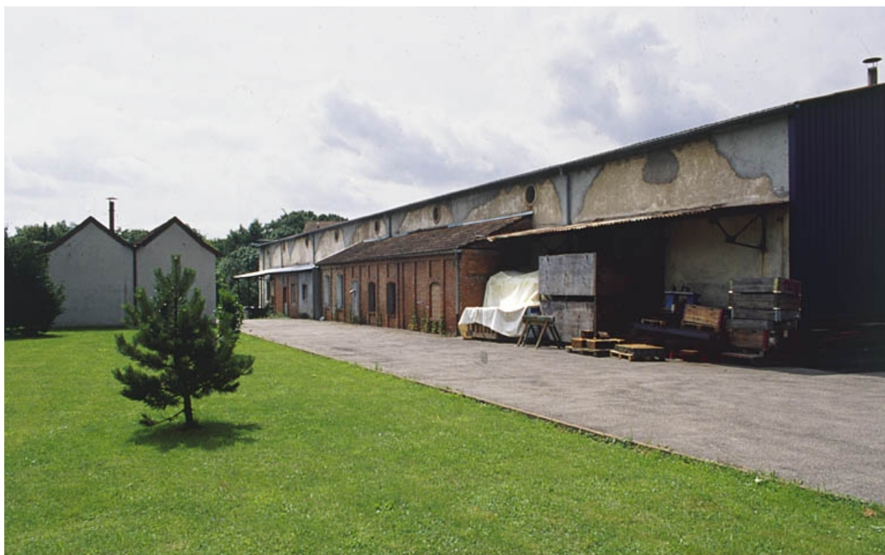
Façade postérieure des ateliers de fabrication.
