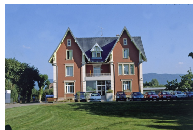
Façade sud-est du logement patronal. Phot. Yves Sancey IVR43_19999000035ZA
