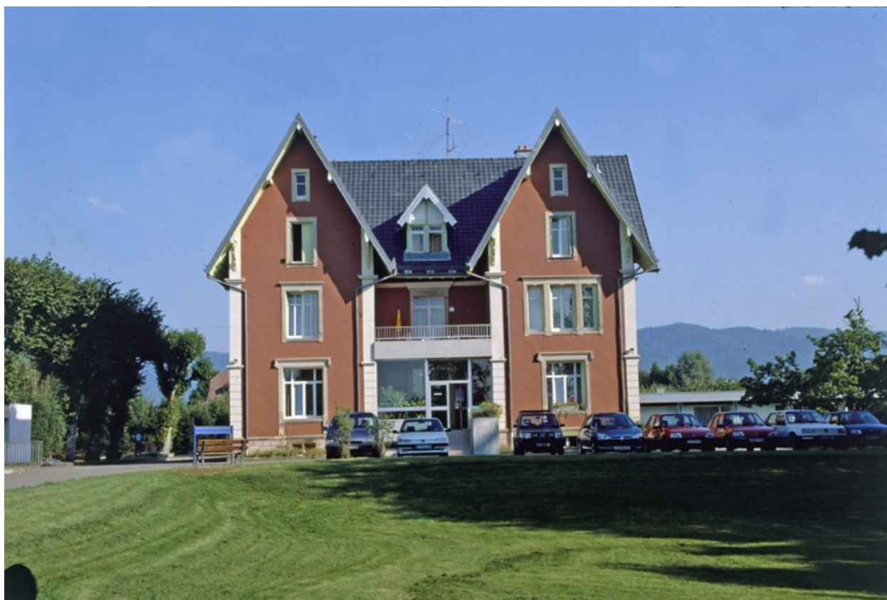
Façade sud-est du logement patronal.
