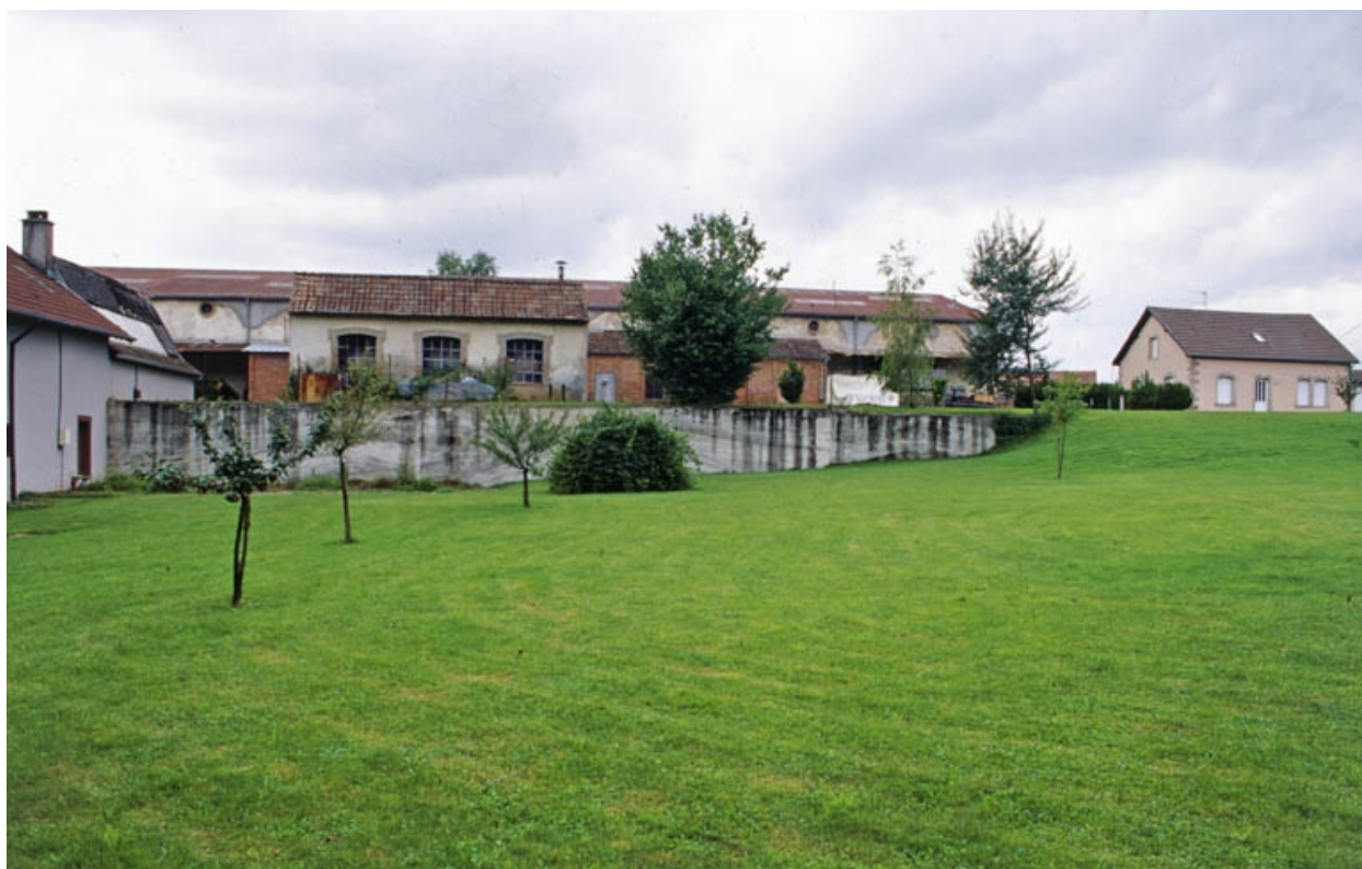
Ateliers de fabrication et conciergerie depuis l'est.
