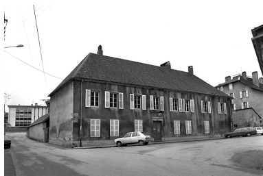
Façade antérieure. Phot. Yves Sancey
