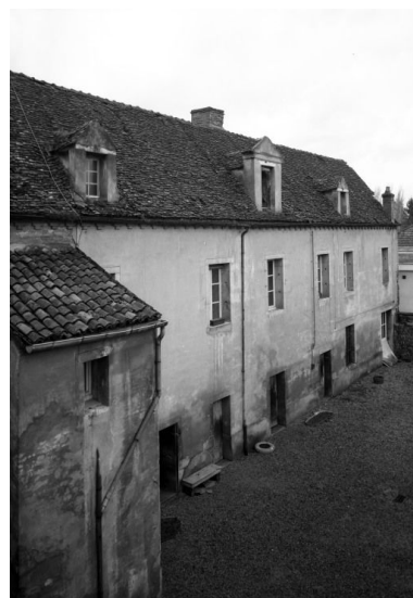
Ancien bâtiment des prisons, façade sur cour. Phot. Michel Rosso IVR26_19862100098V
