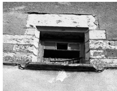
Détail : baie du pignon gauche. Phot. Michel Rosso IVR26_19862100111X
