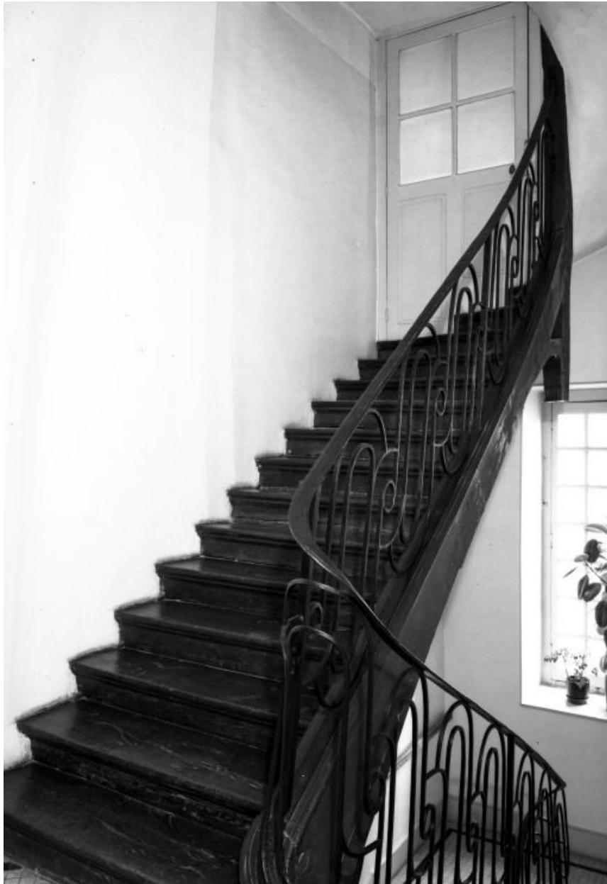
Escalier, volée menant au comble.
