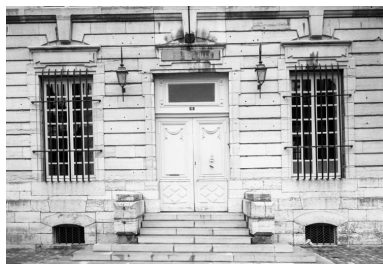
Façade, détail. Phot. Michel Rosso IVR26_19862100095V
