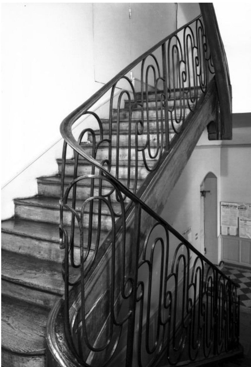
Escalier, première et deuxième volées.
