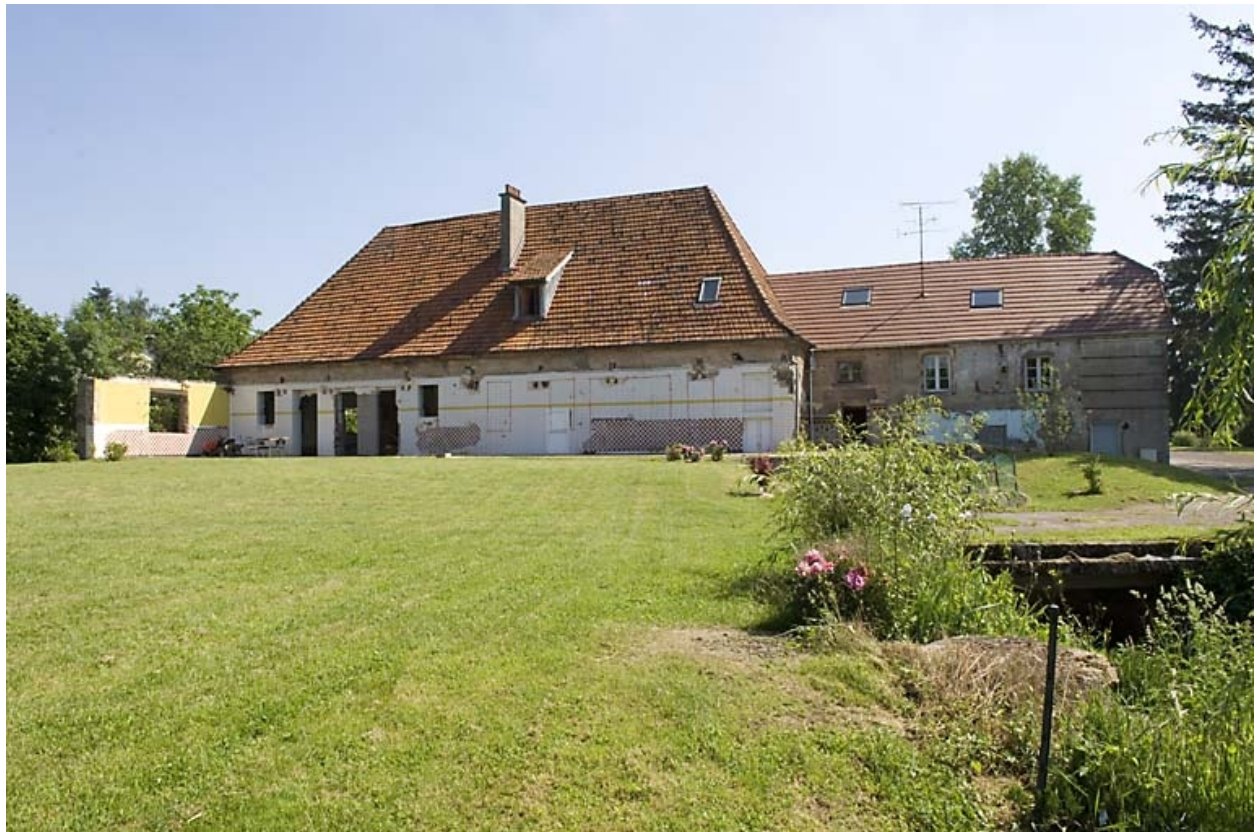
Atelier de fabrication et logement depuis l'ouest.
