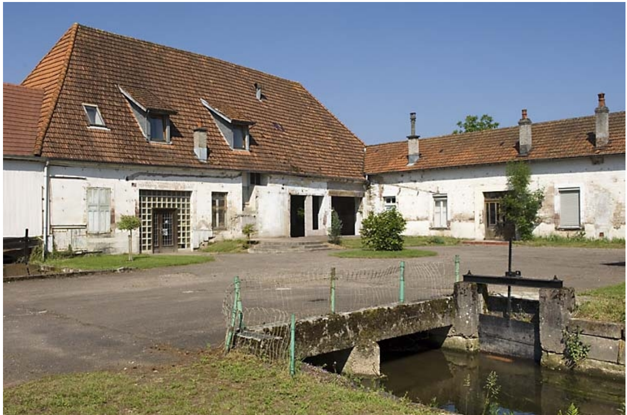
Atelier de fabrication depuis le sud-est.
