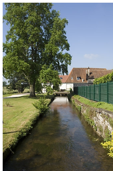
Bief d'amenée. Phot. Jérôme Mongreville IVR43_20077000179NUCA
