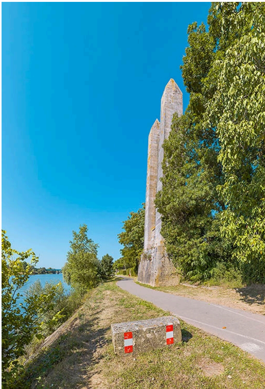
Pylônes de la rive droite, le long de la digue de Chauvort.
