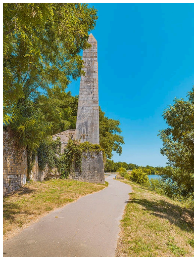
Pylônes de la rive droite, le long de la digue de Chauvort. Phot. Thierry Kuntz IVR26_20207100256NUC4A
