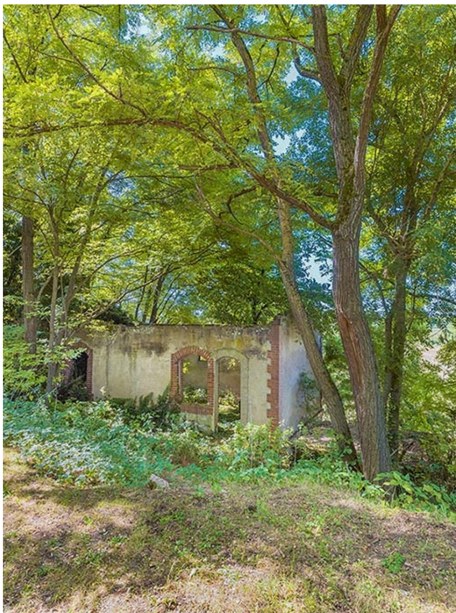
Vestiges d'un bâtiment (magasin ?), rive gauche.
