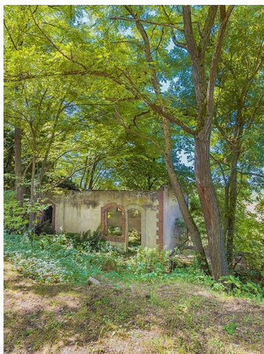
Vestiges d'un bâtiment (magasin ?), rive gauche. Phot. Thierry Kuntz IVR26_20207100244NUC4A
