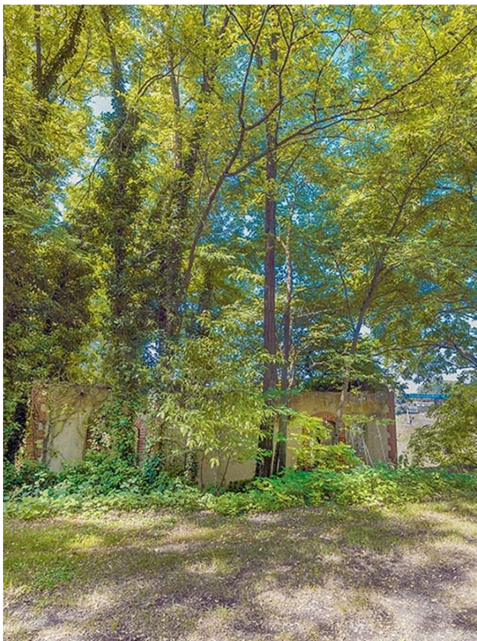
Vestiges d'un bâtiment (magasin ?), rive gauche.
