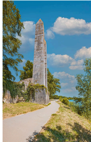
Pylônes de la rive droite, le long de la digue de Chauvort. Phot. Thierry Kuntz IVR26_20207100255NUC4A
