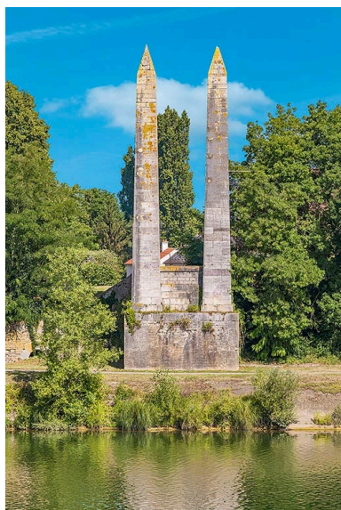
Pylônes de la rive droite. Phot. Thierry Kuntz IVR26_20207100250NUC4A
