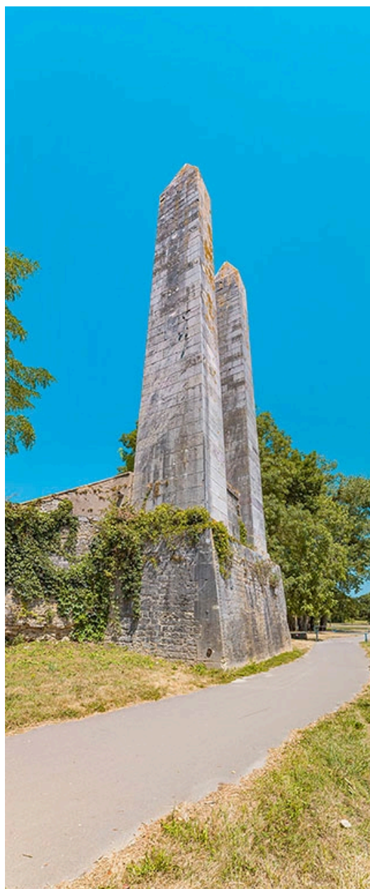
Pylônes de la rive droite, le long de la digue de Chauvort. Echelle de crue.
