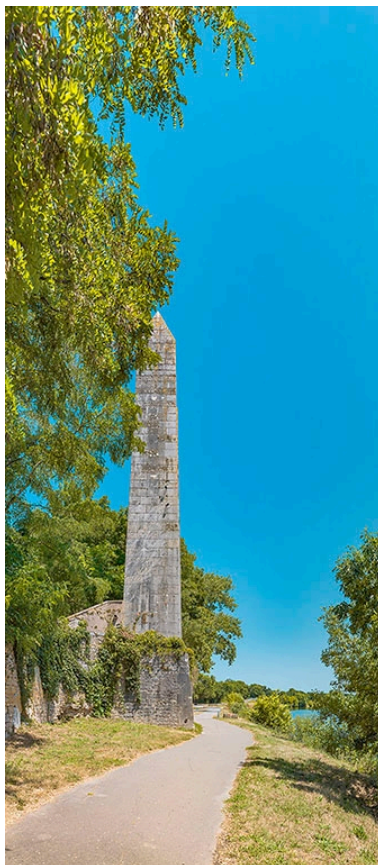
Pylônes de la rive droite, le long de la digue de Chauvort. Phot. Thierry Kuntz IVR26_20207100257NUC4A
