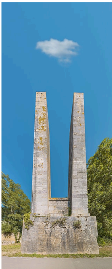
Pylônes de la rive droite. Phot. Thierry Kuntz IVR26_20207100251NUC4A
