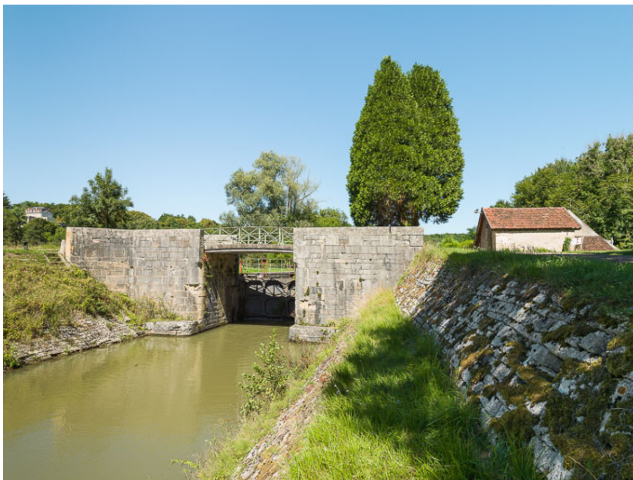
Vue d'ensemble du pont.
