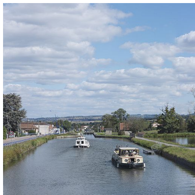
Echelle d'écluses depuis le pont sur l'écluse 01. Phot. Thierry Kuntz IVR26_20127100312NUC4A
