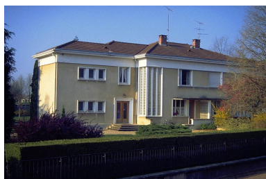
Façade antérieure. Phot. Laurent Poupard IVR43_19893900524ZA
