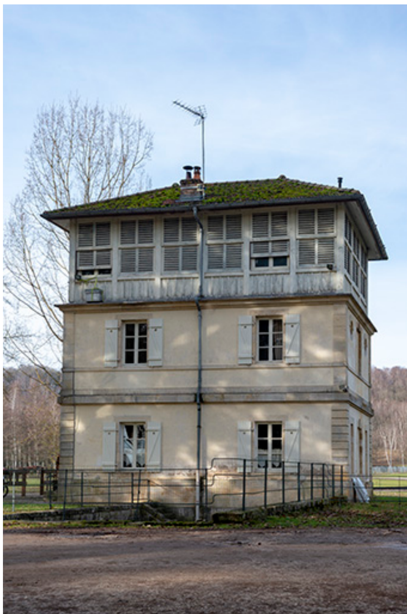
Façade sud-ouest et façade nord-ouest.
