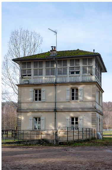
Façade sud-ouest et façade nord-ouest. Phot. Jérôme Mongreville IVR43_20197000132NUC4A
