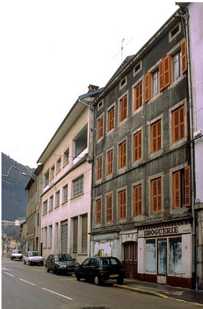
Façades postérieures de trois quarts droite.
