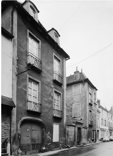
Façade principale, vue de 3/4 gauche.
