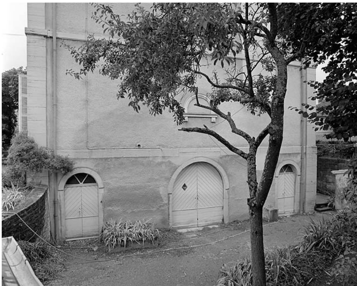
Façade latérale droite.
