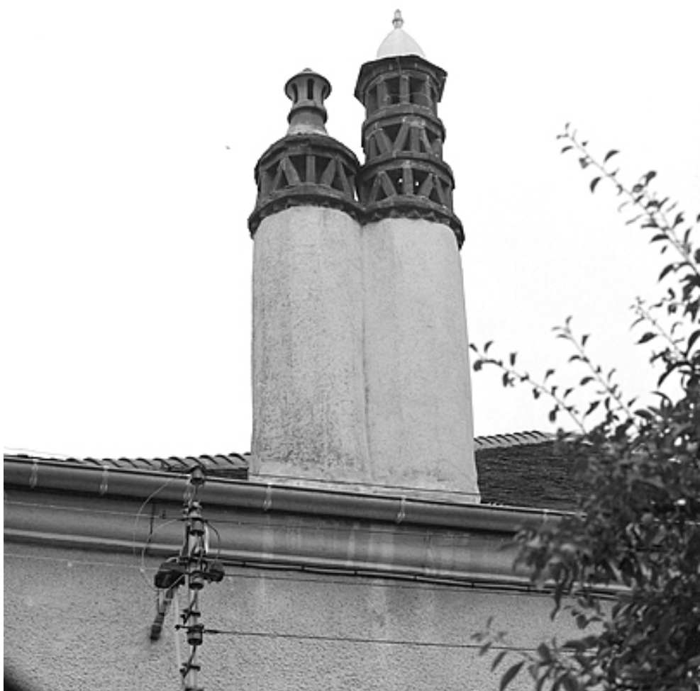
Souches de cheminée.
