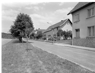
Vue de la rue d'Epercy. Phot. Jérôme Mongreville IVR43_19973900889X
