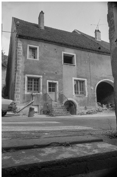
Partie habitation. Phot. Bernard Lardière IVR43_19817000858Z
