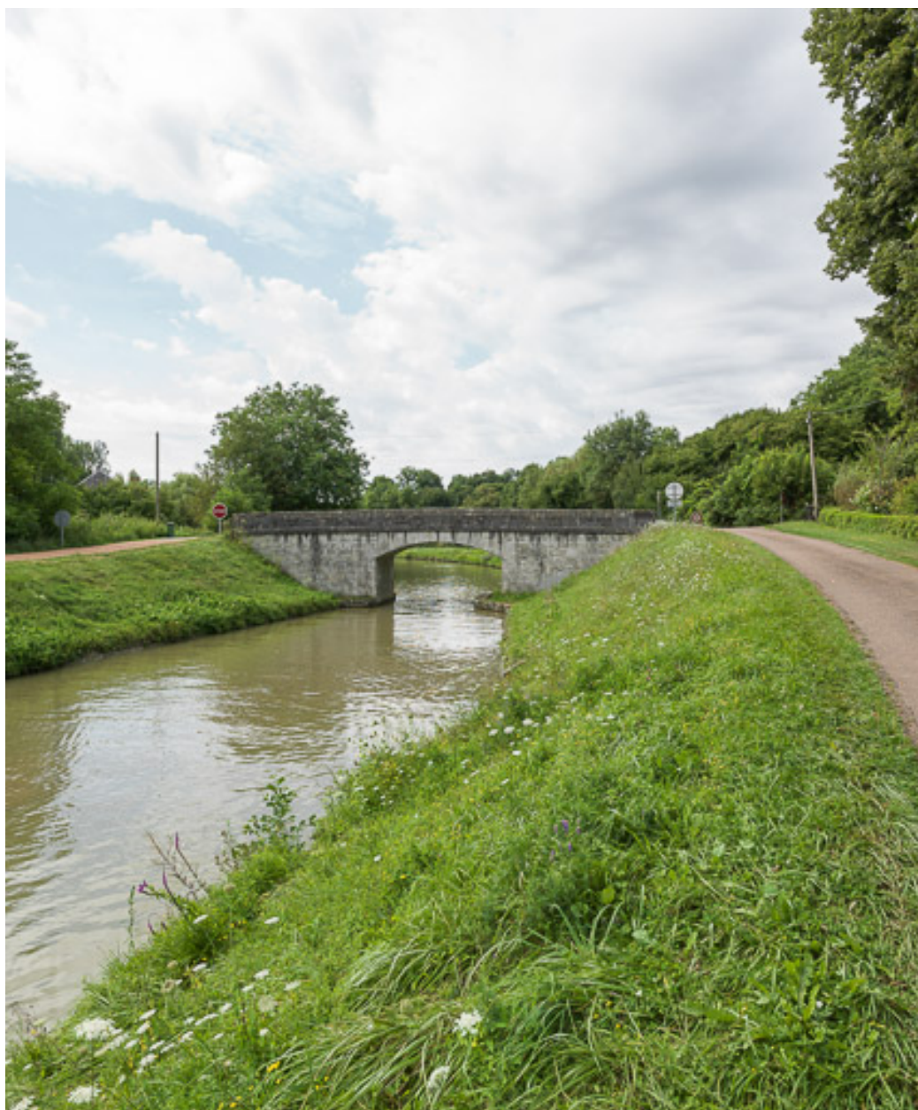
Vue d'ensemble du pont.
