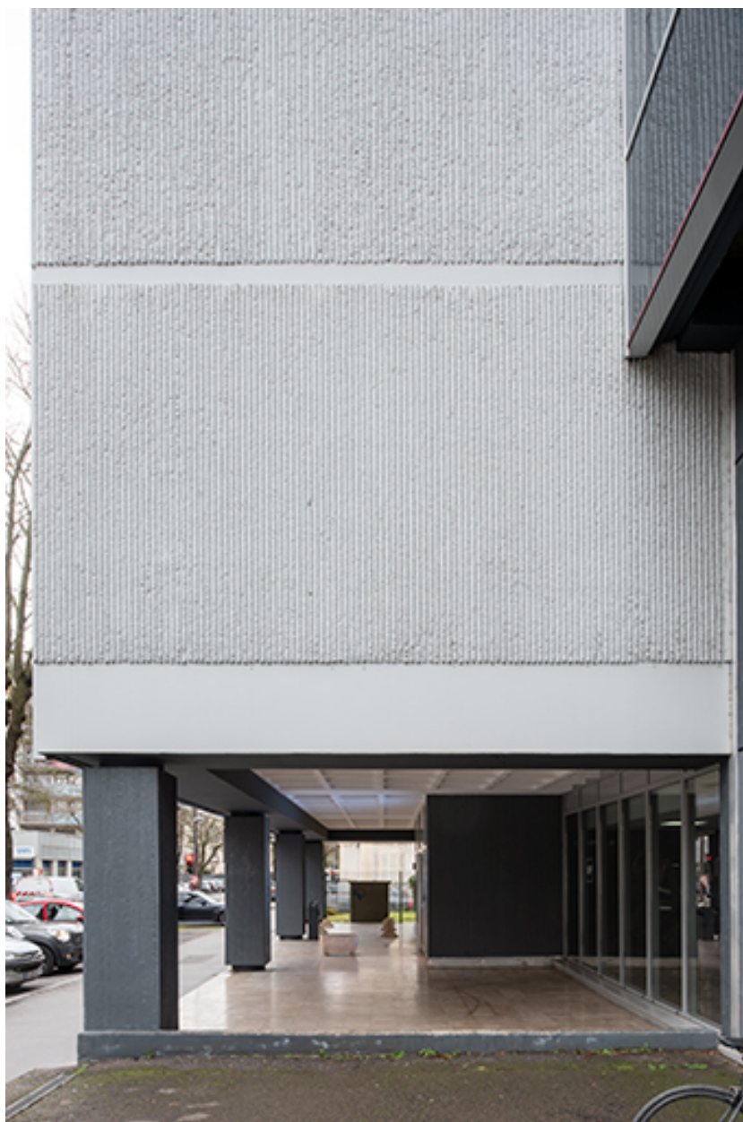
Façade nord-ouest, détail : avant-corps nord-est.
