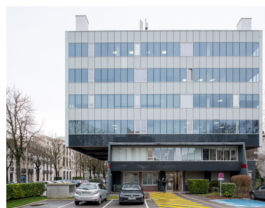
Façade sud-ouest. Phot. Nicolas Waltefaugle IVR26_20262100103NUC4
