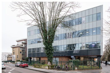
Façade nord-est. Phot. Nicolas Waltefaugle IVR26_20262100109NUC4
