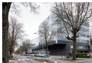
Situation sur le boulevard Carnot, vue depuis le sud-ouest. Phot. Nicolas Waltefaugle IVR26_20262100102NUC4
