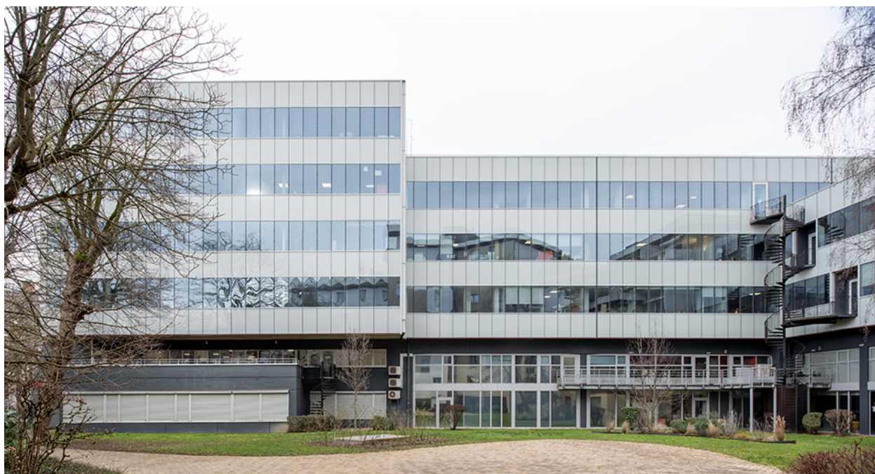
Façade sud-est, partie donnant sur le jardin.
