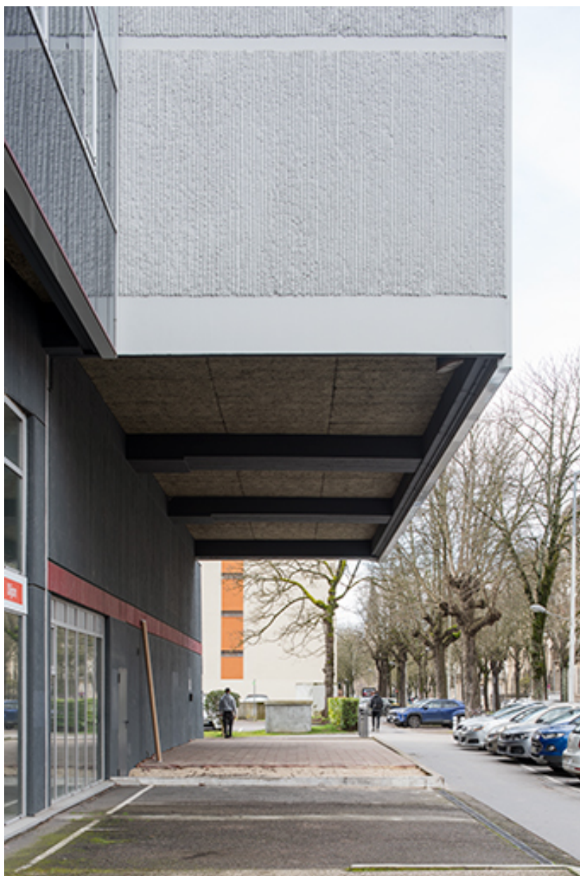
Façade nord-ouest, détail : avant-corps sud-ouest.
