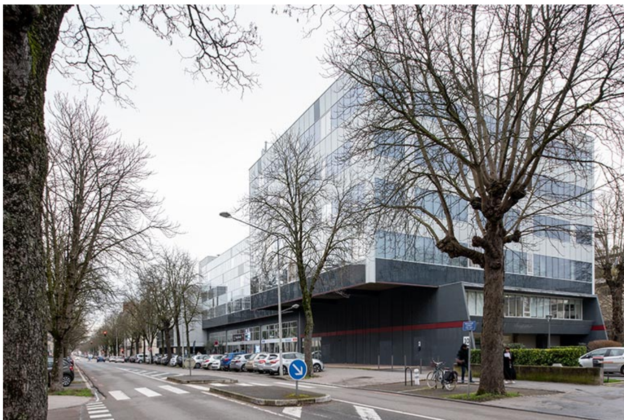
Situation sur le boulevard Carnot, vue depuis le sud-ouest.
