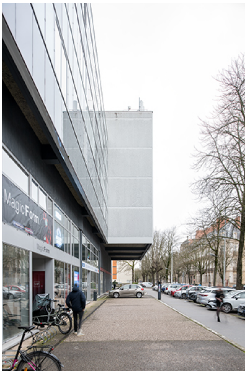
Façade nord-ouest, détail : avant-corps sud-ouest.
