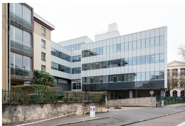
Façade sud-est, partie donnant sur la rampe d'accès, rue Prieur-de-la-Côte-d'Or. Phot. Nicolas Waltefaugle IVR26_20262100112NUC4
