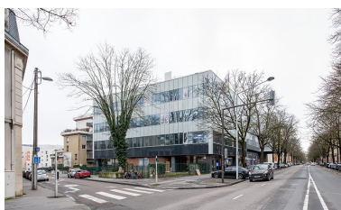
Situation sur le boulevard Carnot, vue depuis le nord. Phot. Nicolas Waltefaugle IVR26_20262100108NUC4
