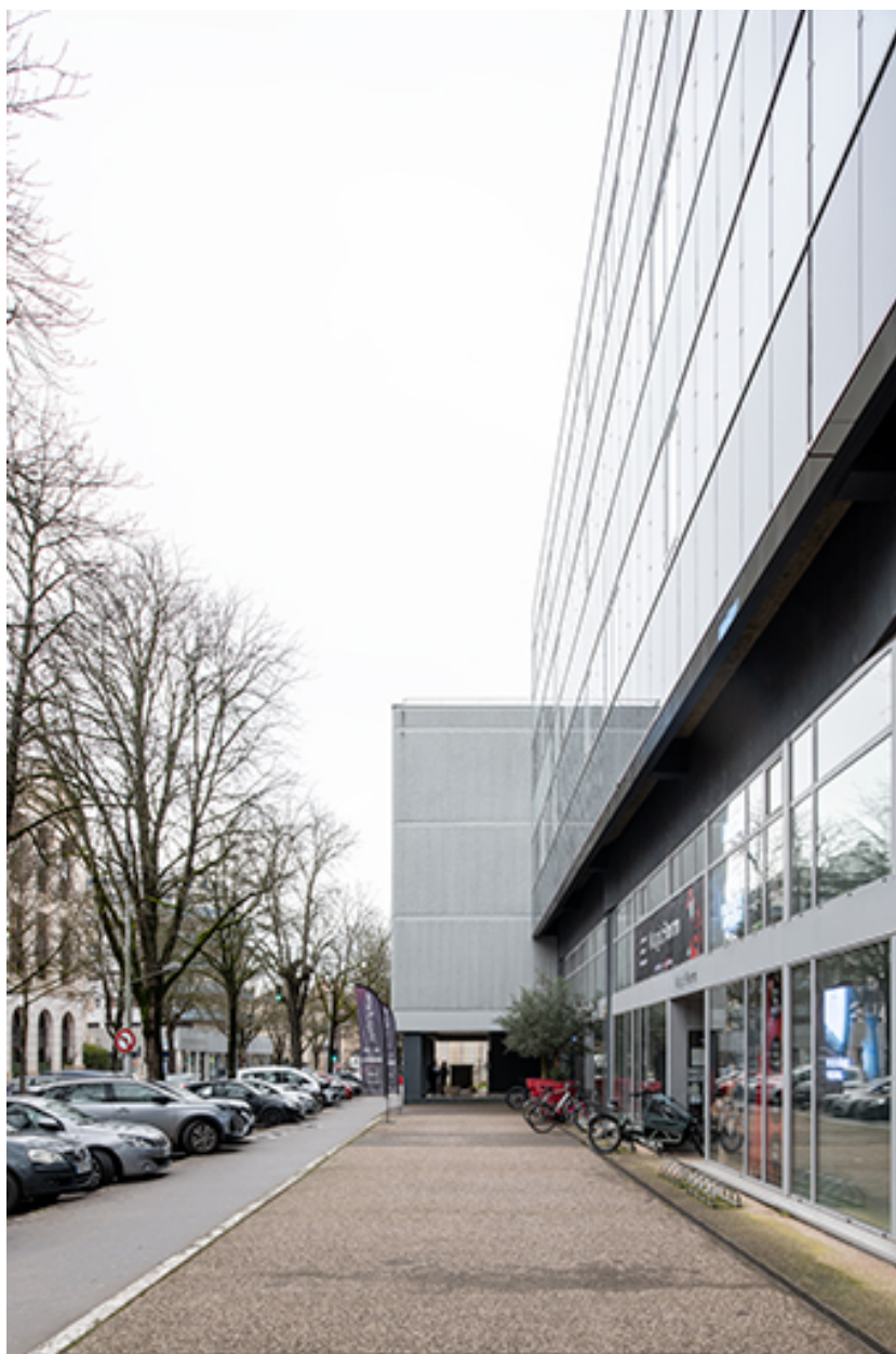
Façade nord-ouest, détail : avant-corps nord-est.
