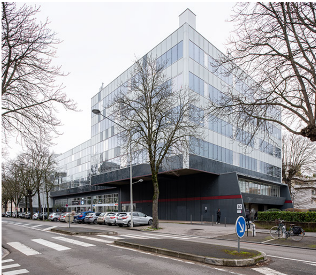
Façade nord-ouest et façade sud-ouest.
