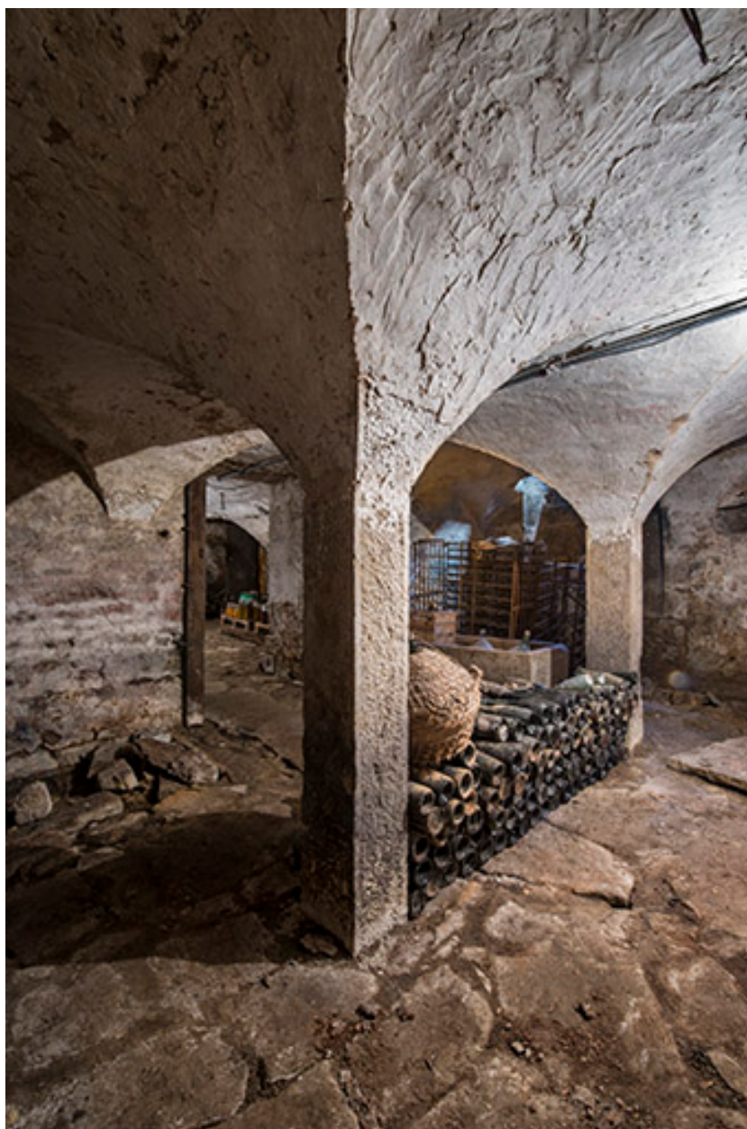
Détail d'une colonne supportant les voûtes.
