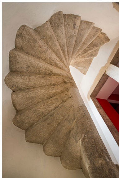
Vue en contre-plongée de l'escalier. Phot. Jérôme Mongreville IVR43_20187000055NUC4A
