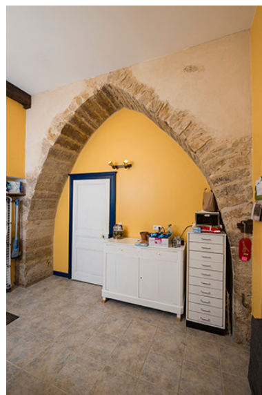
Voûte en tiers-point, arrière cuisine. Phot. Jérôme Mongreville IVR43_20187000051NUC4A
