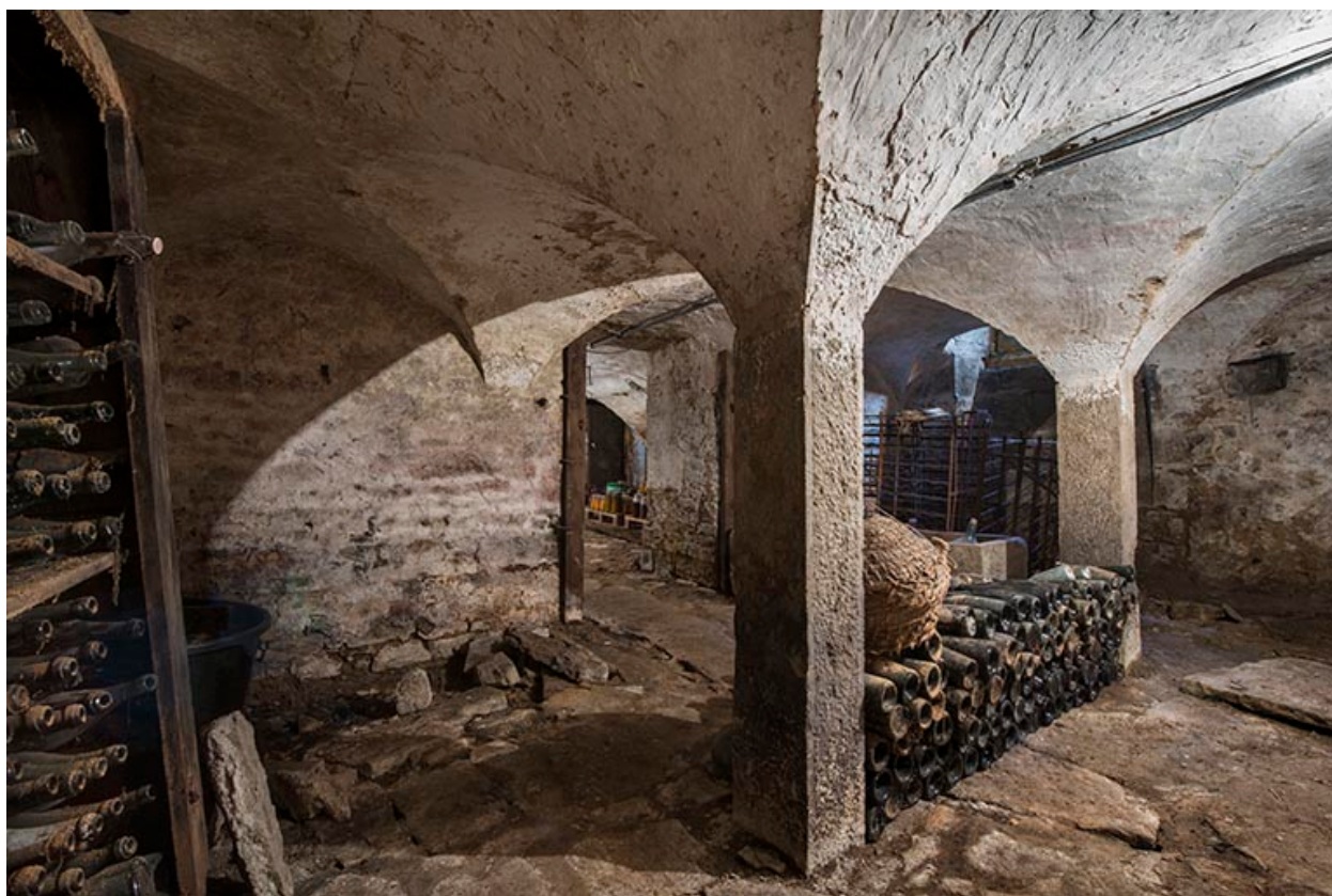
La cave, partie voûtée sur colonnes.
