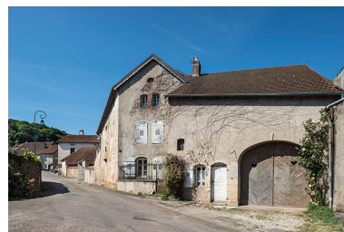
Vue depuis le bas de la rue. Phot. Jérôme Mongreville IVR43_20177001287NUC4A
