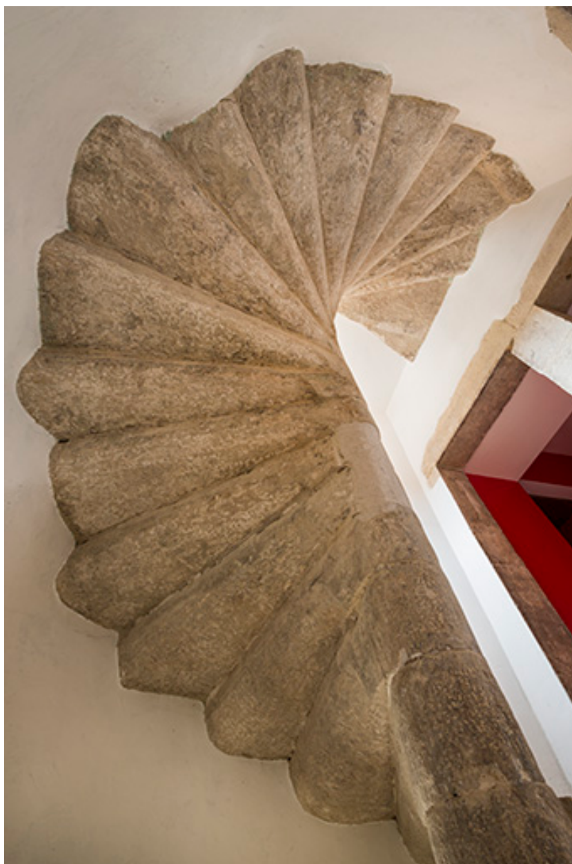
Vue en contre-plongée de l'escalier.
