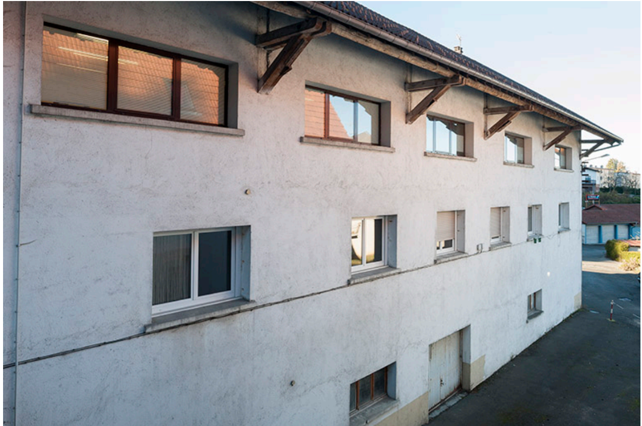
Atelier de fabrication : façade postérieure, de trois quarts gauche.
