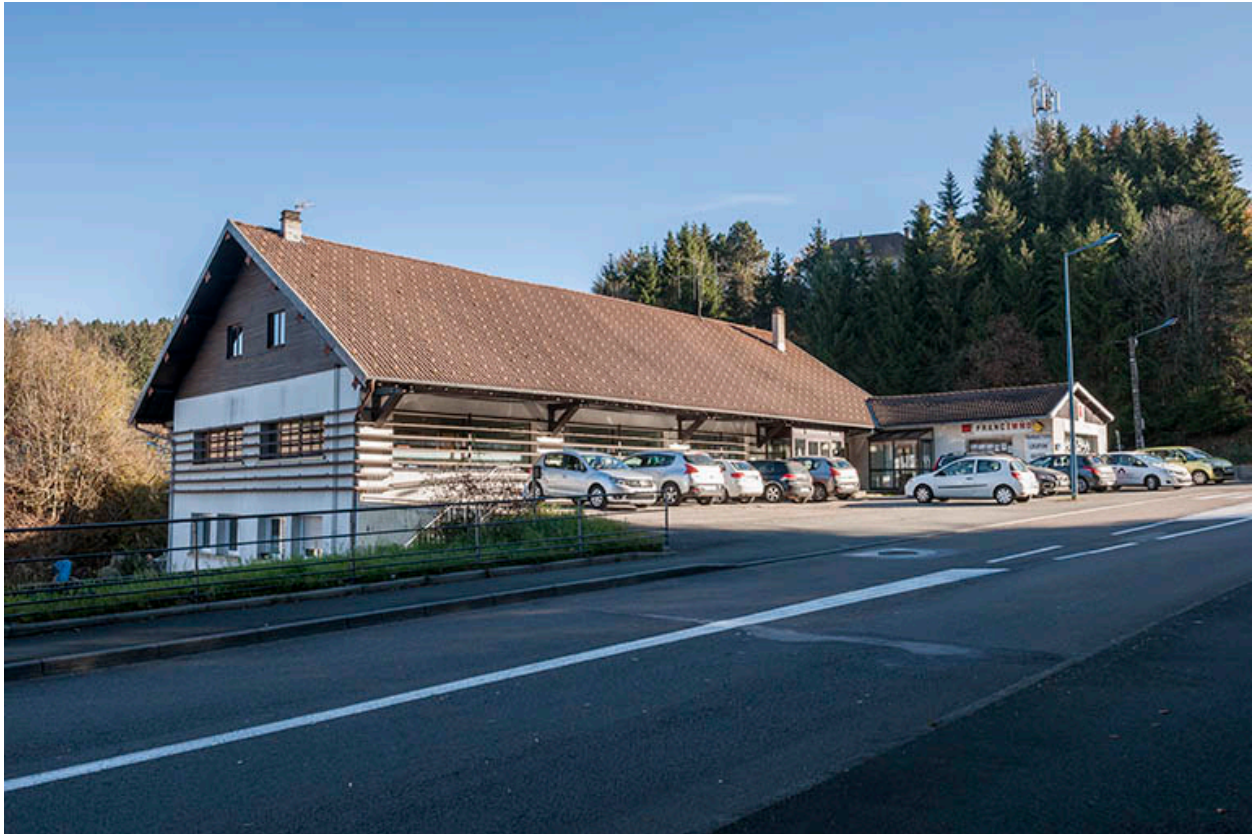
Atelier de fabrication et bureau récent, depuis l'ouest.
