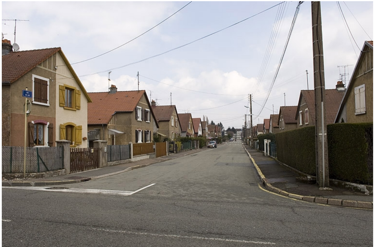
Vue d'ensemble de la rue Bel Air.
