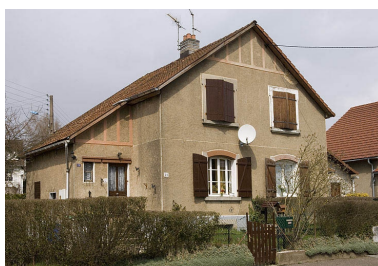
Maison à deux logements (côté impair). Phot. Jérôme Mongreville IVR43_20067000161NUCA
