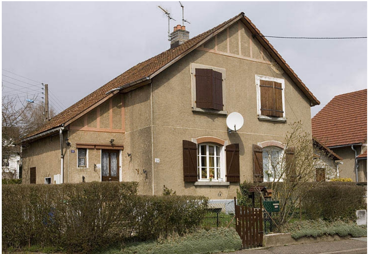
Maison à deux logements (côté impair).
