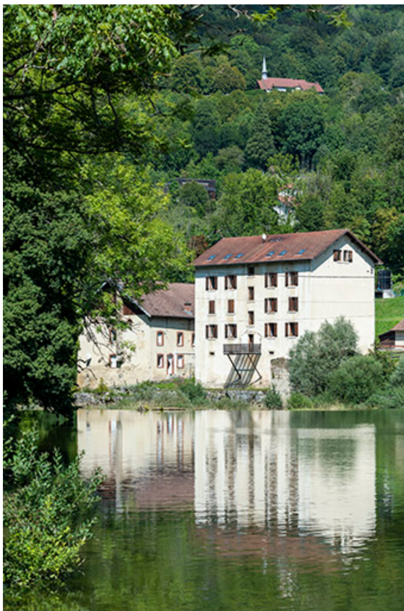
Façades postérieure et latérale gauche.
