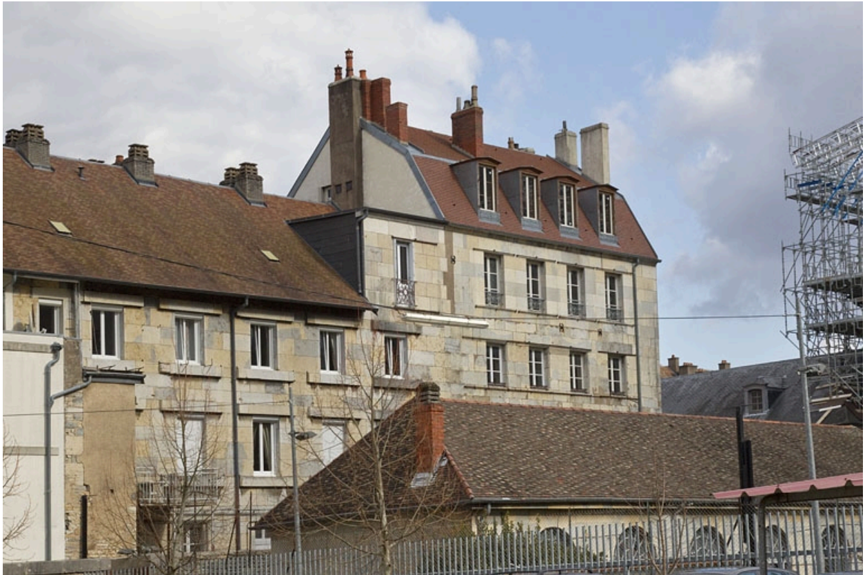
Vue éloignée de l'arrière de l'édifice.
