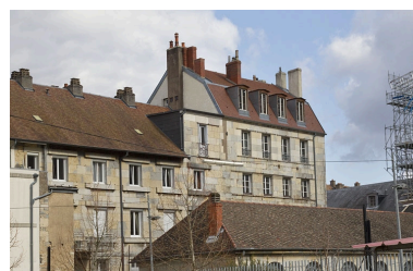
Vue éloignée de l'arrière de l'édifice.
