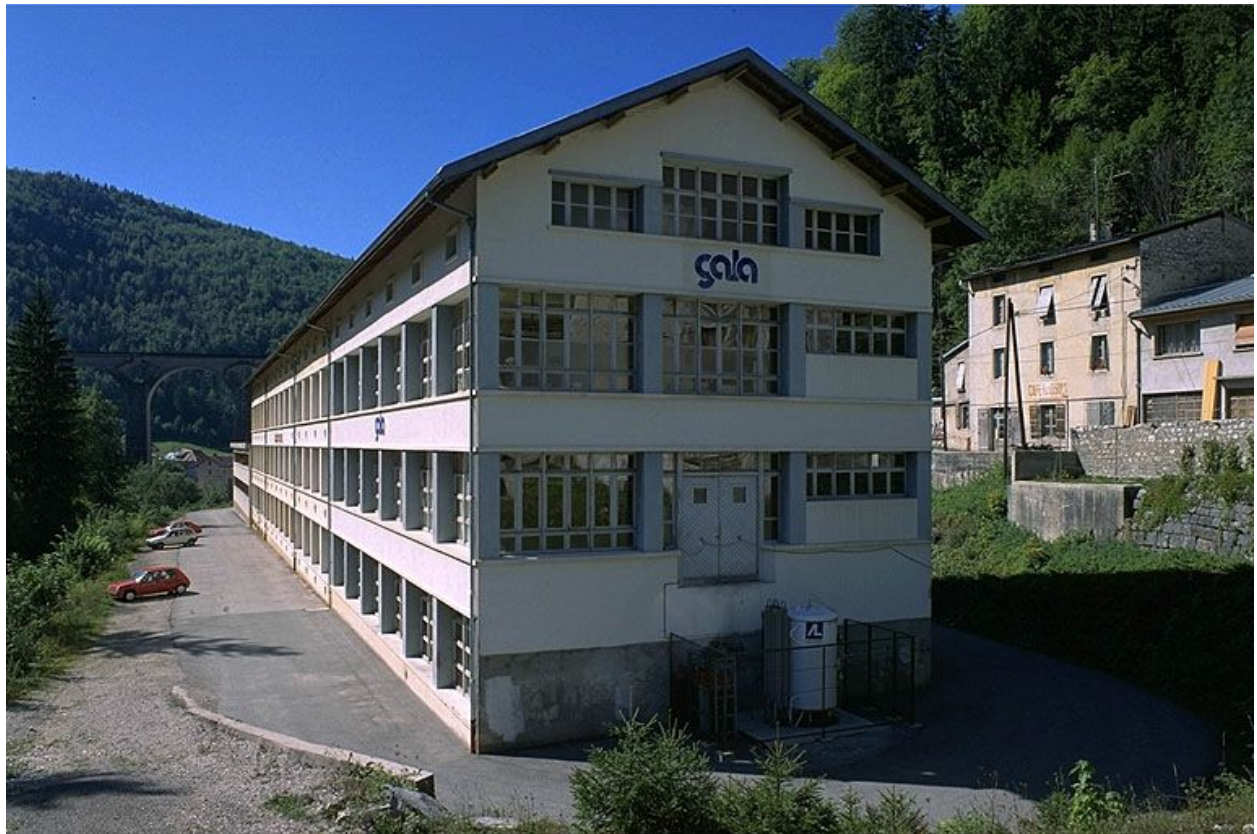
Façades postérieure et latérale gauche.
