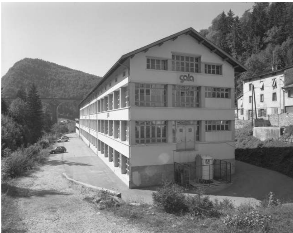
Façades postérieure et latérale gauche.
