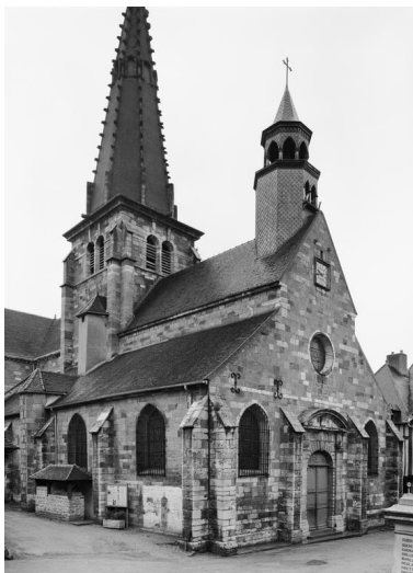
Façade et élévation gauche de la nef. Phot. Michel Thierry IVR26_19792101911V
