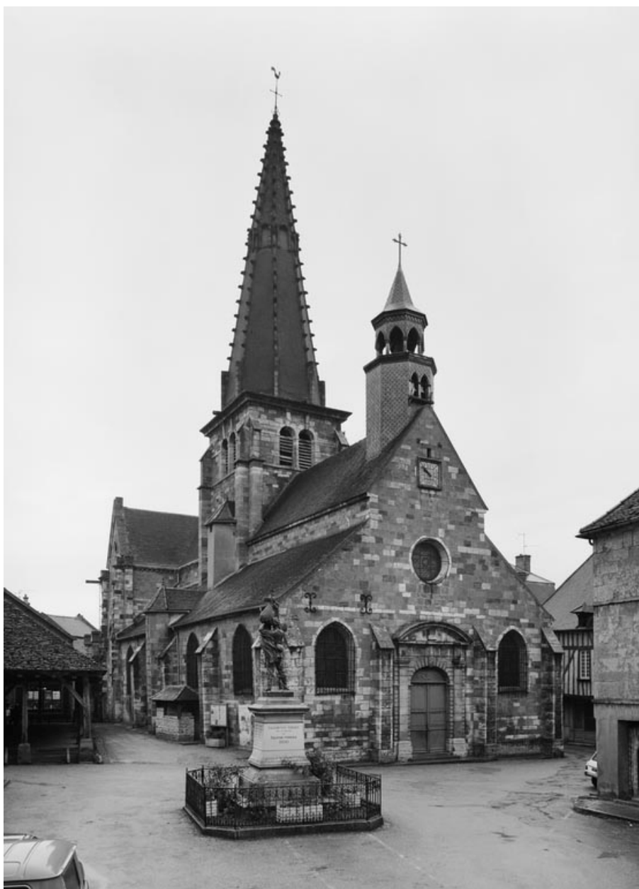
Vue d'ensemble, de 3/4 gauche.
