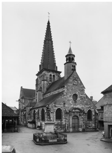
Vue d'ensemble, de 3/4 gauche. Phot. Michel Thierry IVR26_19792101907V
