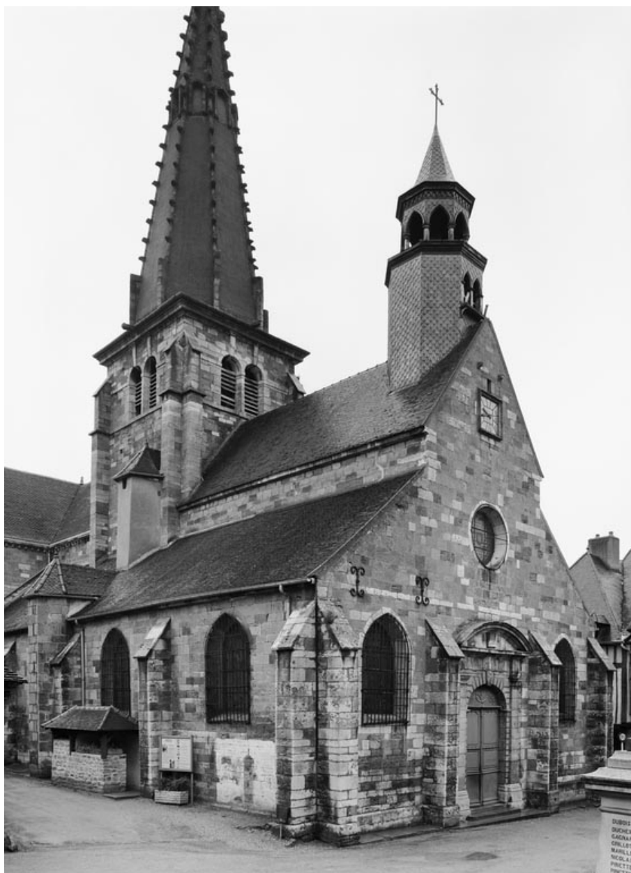
Façade et élévation gauche de la nef.
