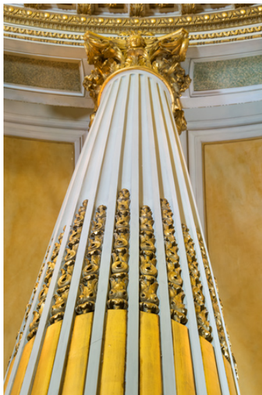
Une colonne, vue en contre-plongée. Phot. Pierre-Marie Barbe-Richaud IVR26_20257100288NUC4A
