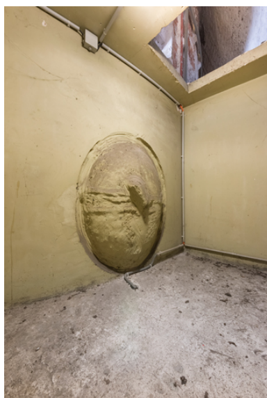
Verso de la niche côté jardin. Phot. Pierre-Marie Barbe-Richaud IVR26_20257100252NUC4A
