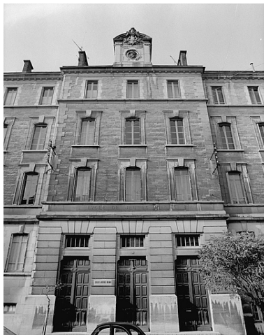
Façade antérieure, avant-corps central. Phot. Yves Sancey IVR43_19833900600X
