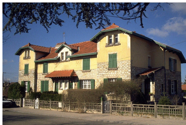
Façade antérieure vue de trois quarts. Phot. Laurent Poupard IVR43_19893900548ZA
