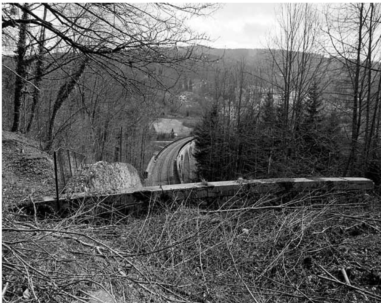
Tête côté Andelot-en-Montagne : partie supérieure de la tranchée couverte.
