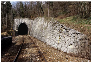
Vue d'ensemble de la tête côté Andelot-en-Montagne. Phot. Yves Sancey IVR43_20053900528ZA
